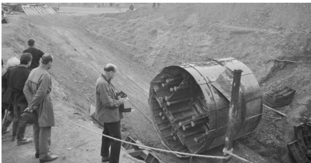
Obrázek 1: Zahájení stavebních prací na metru v roce 1969 (Reflex, 2019)
