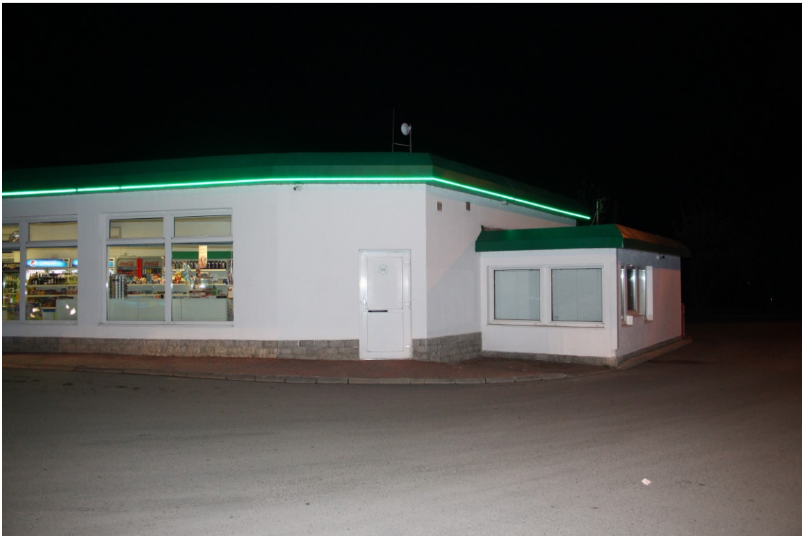
Obrázek č. 22 celková fotografie (vloupání do objektu – čerpací stanice)
