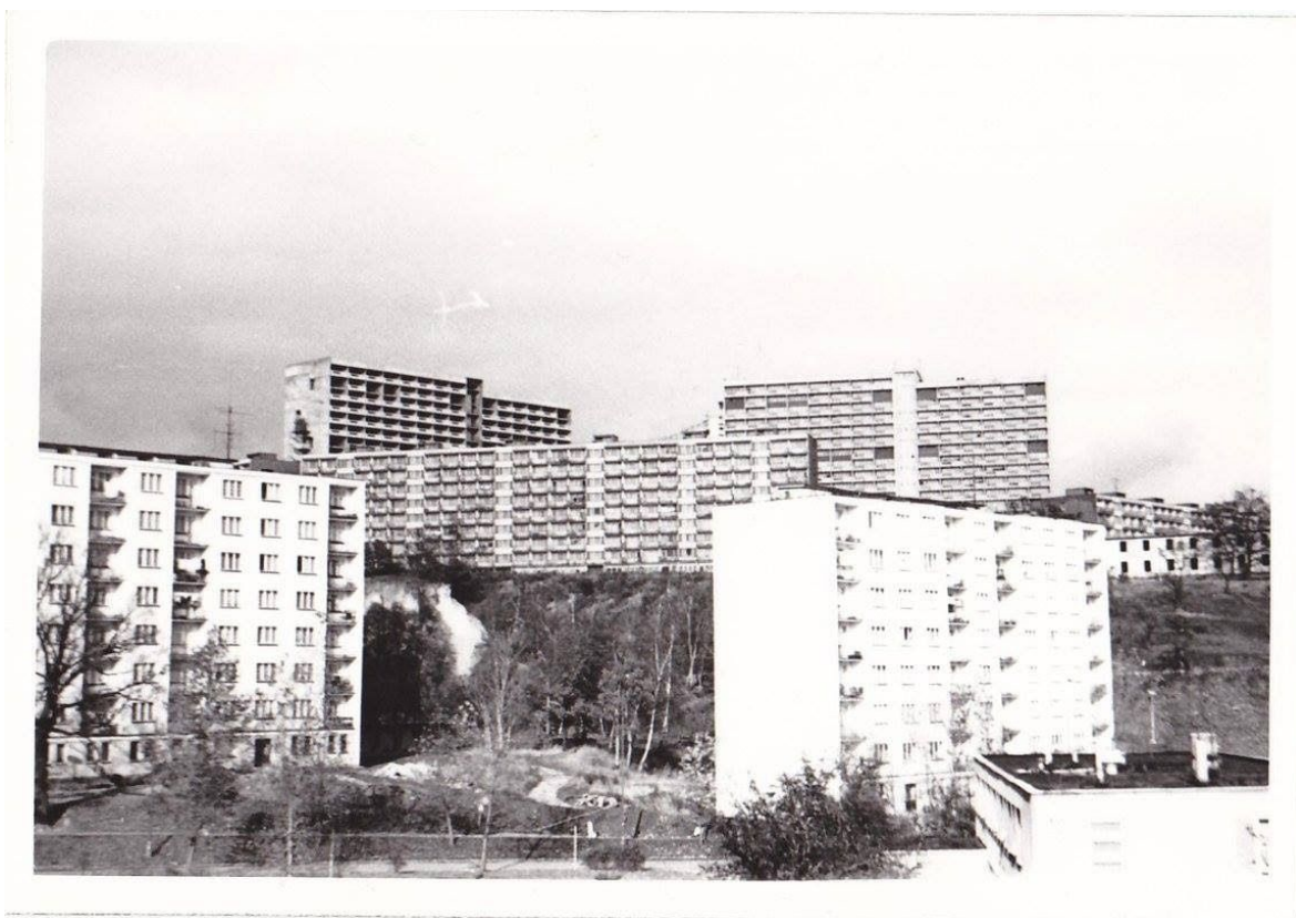
Obrázek 5: Sídlíště Březenecká ve výstavbě. Vidět jsou dva ze tří experimentálních domů, mezi ostatní zástavbou vynikají výškou. (Zdroj: Odbor rozvoje a investic města Chomutov)
