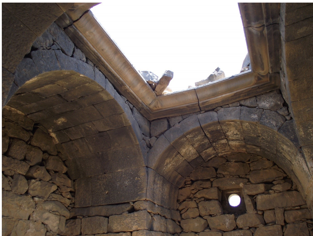
Obr. 4 Křížová klenba - Praetorium v Umm el Džimalu (vlastní archiv)
