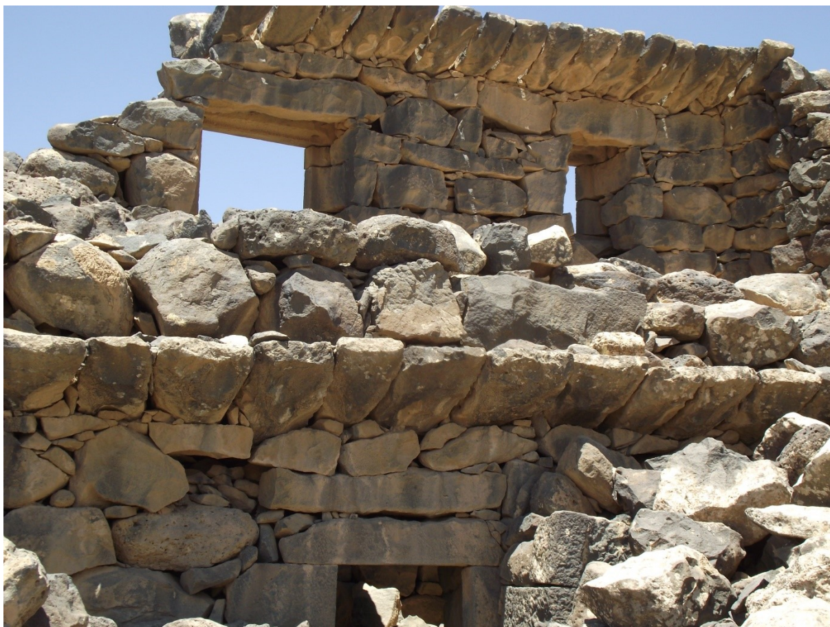
Obr. 5 Konzole - Kasárna v Umm el-Džimalu (vlastní archiv)
