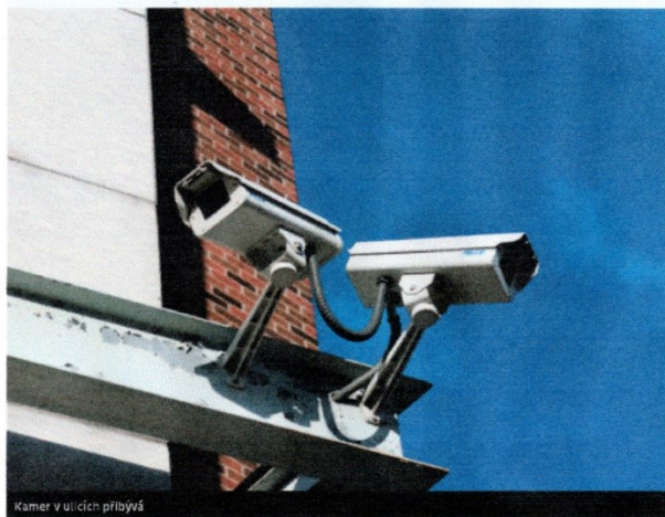
Kamer v ulicích přibývá
