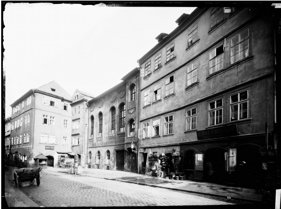
Abbildung 16: Josefstädter Gasse mit Neusynagoge (das Gebäude mit den Rundbogenfenstern), um 1895.
