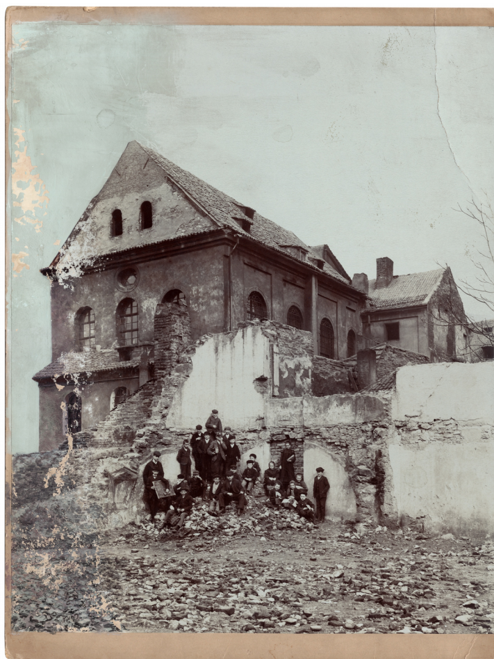
Abbildung 17: Die Zigeunersynagoge kurz vor ihrem Abriss, 1906.
