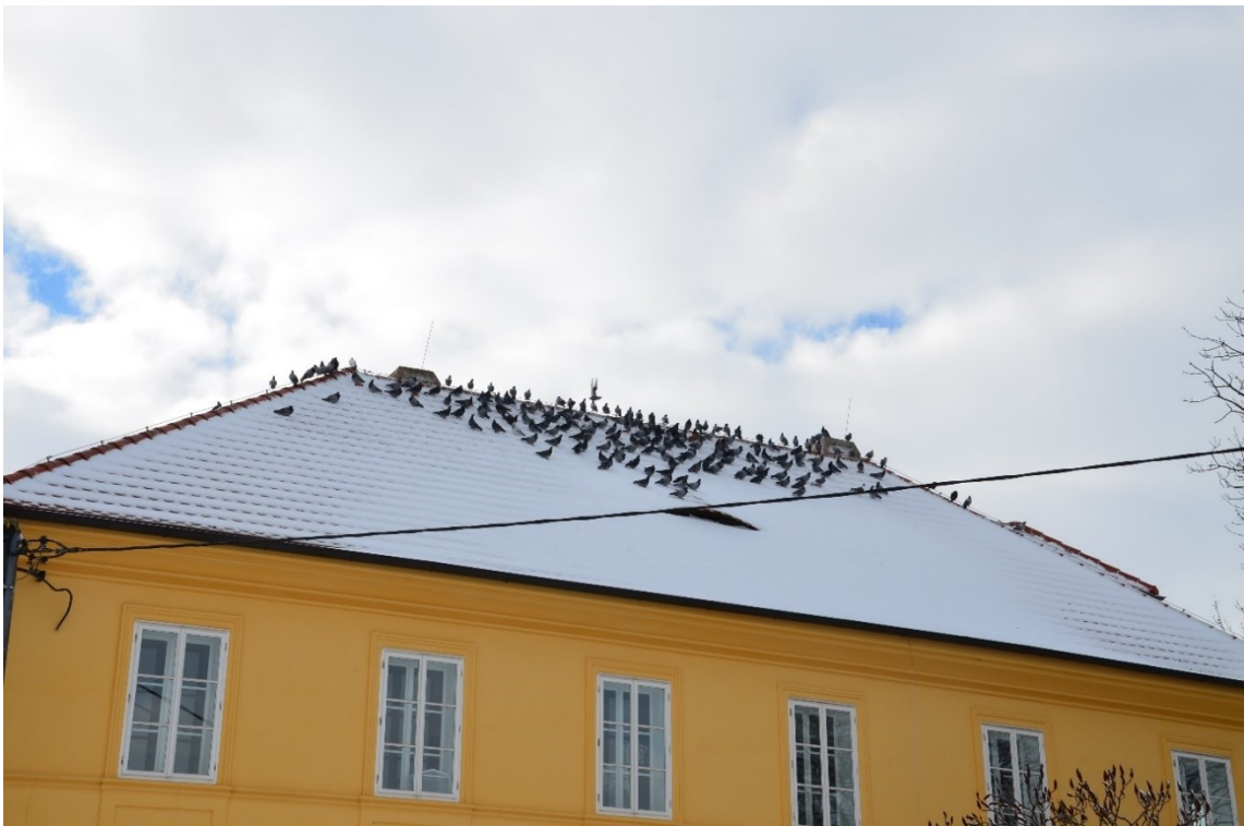
Obr. 4 Budova D byla součástí hospodářského komplexu, kde byla umístěna klecová past (viz odchyť). Na severní střeše budovy D se množství holubů v průběhu dne snižovalo. Foto: David M.
