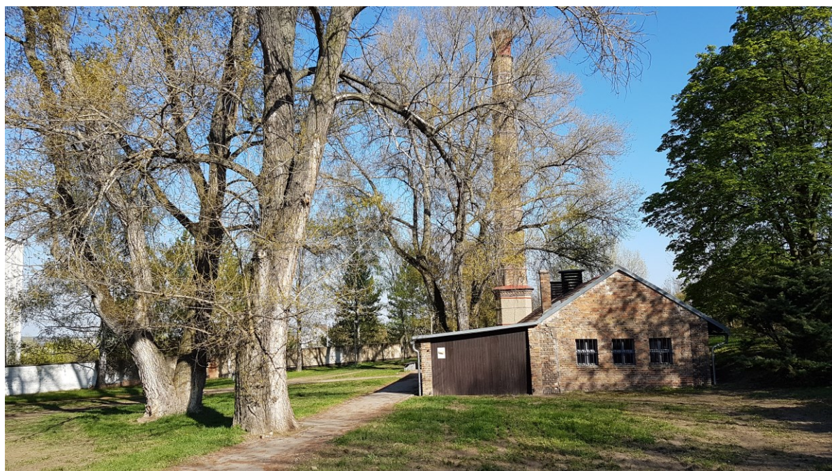
Příloha č. 26: Budova krematoria, jaro 2019.
