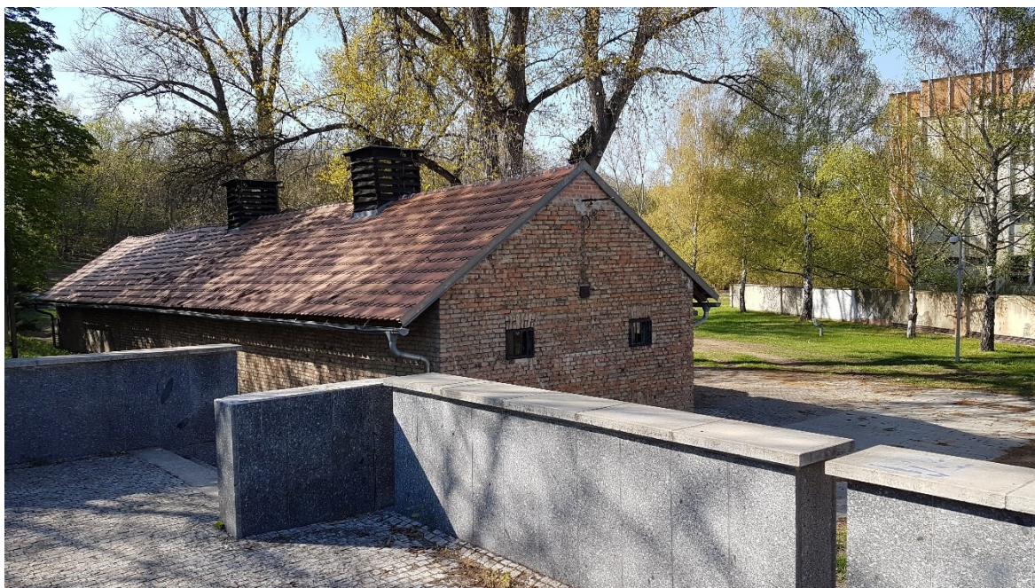
Příloha č. 25: Budova krematoria, jaro 2019.
