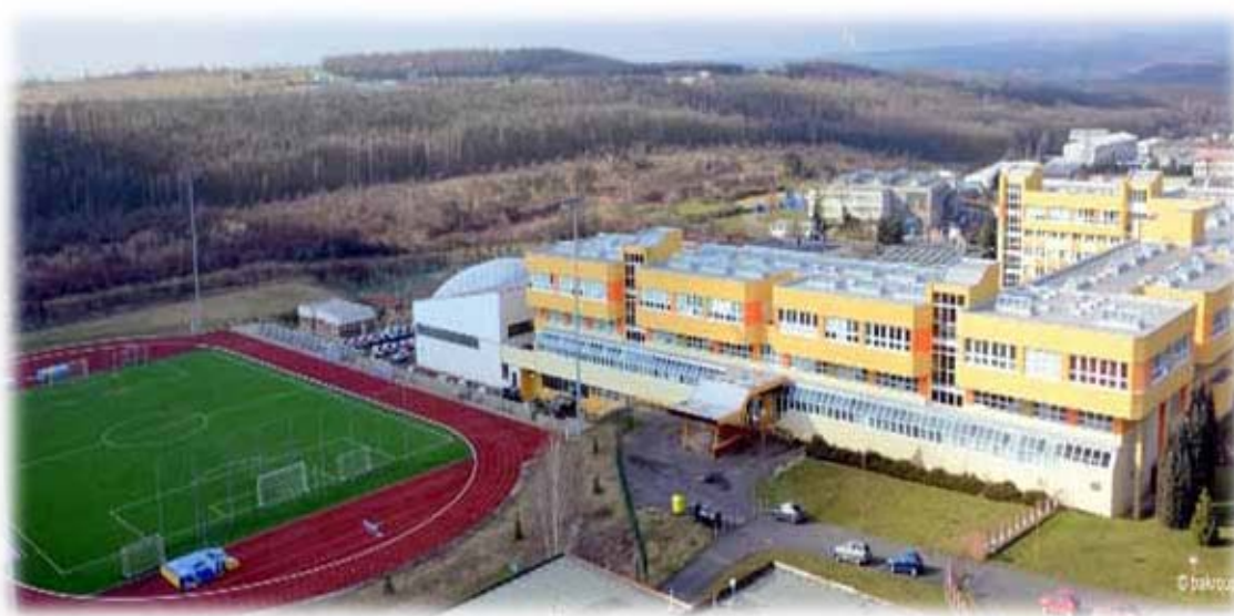
Obrázek 4.1 Opravené budovy SST Most se sportovním zázemím
