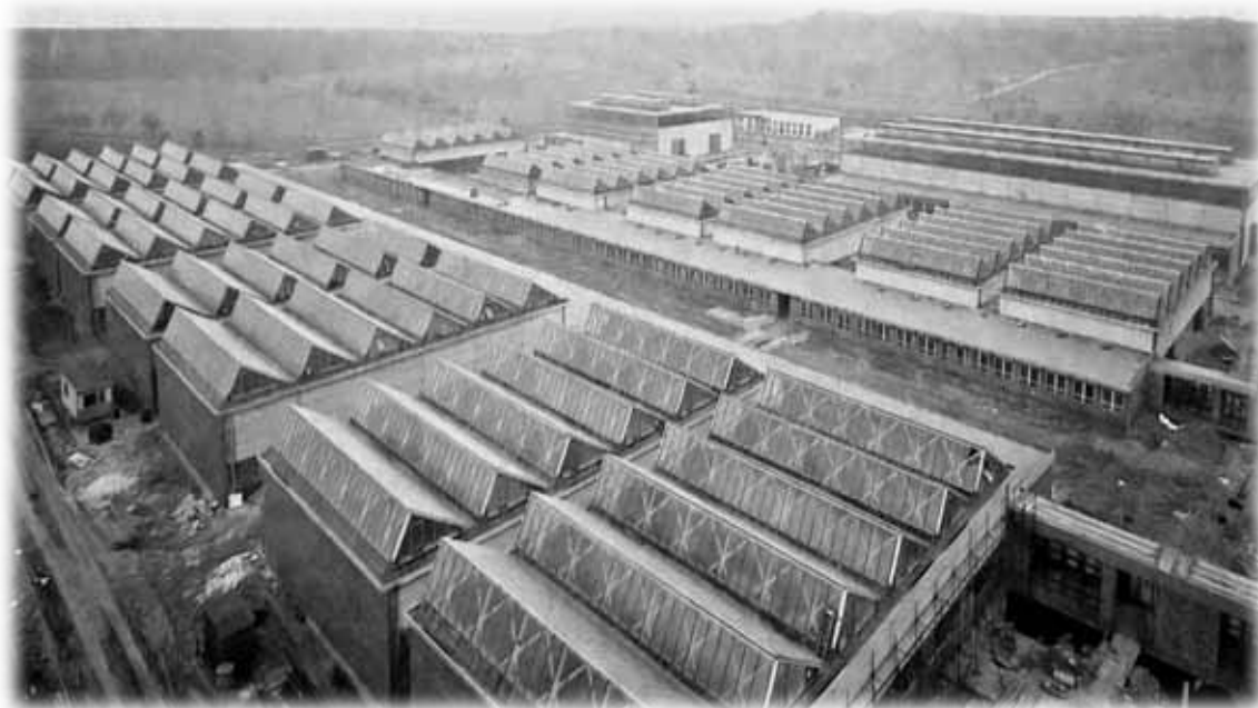
Obrázek 3.6 Budovy dílen nového učiliště SHD, 1980
