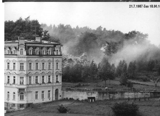
Demolice evanjelického kostela 166
