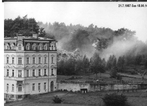
Demolice evanjelického kostela 36
