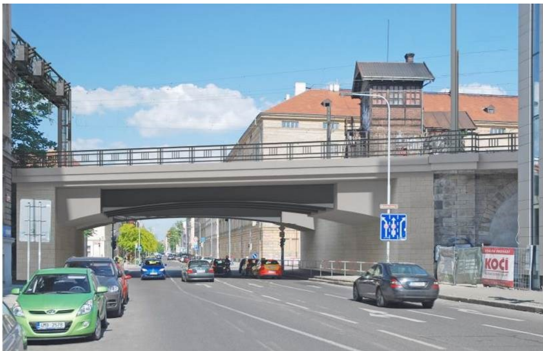
18) Stav po rekonstrukci, ulice Sokolovská
