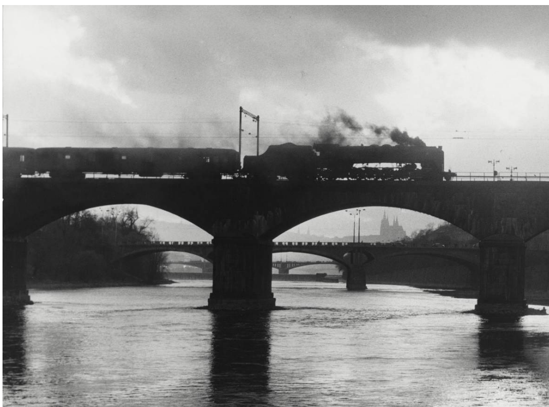
10) Panorama Negrelliho viaduktu a dalších pražských mostů, foto: Zdeněk Bauer, 27. 3. 1972, MMP
