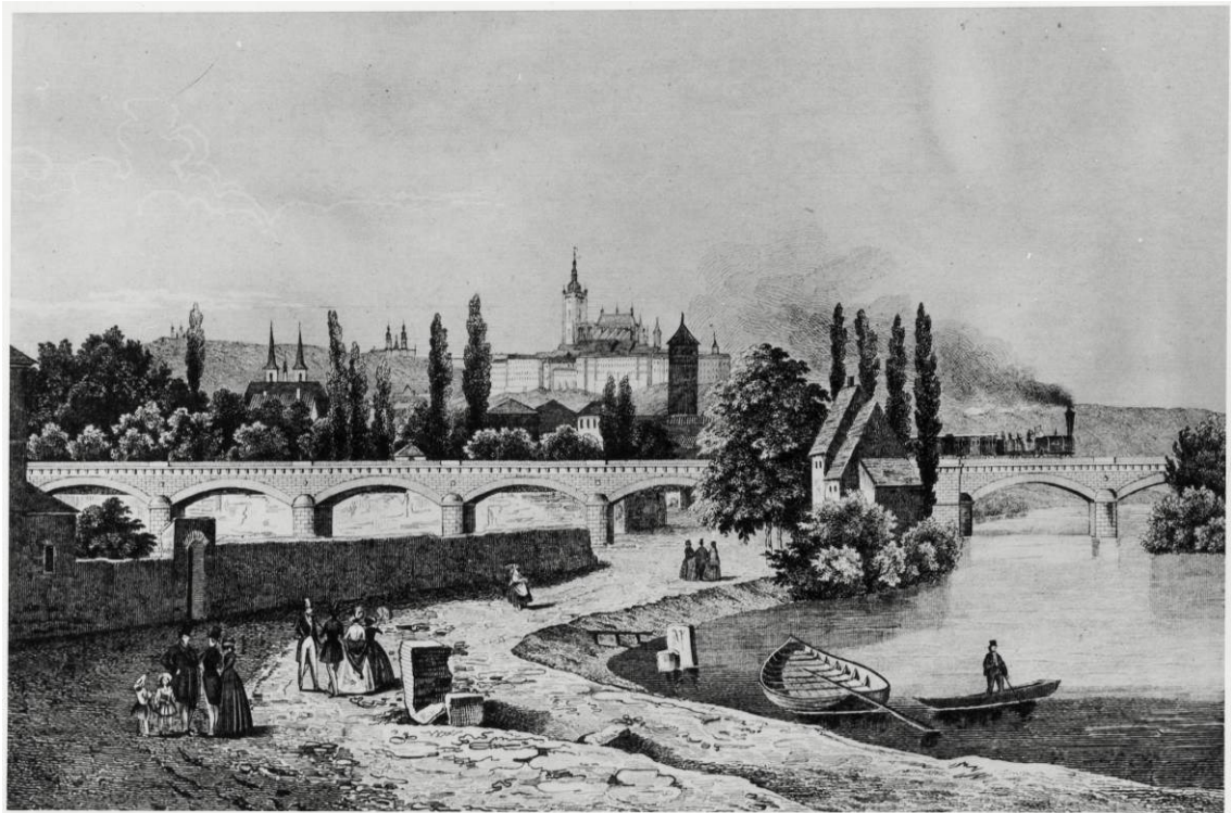
5) Negrelliho viadukt, v pozadí Hradčany, Josef Richter, litografie, 1852, MMP
