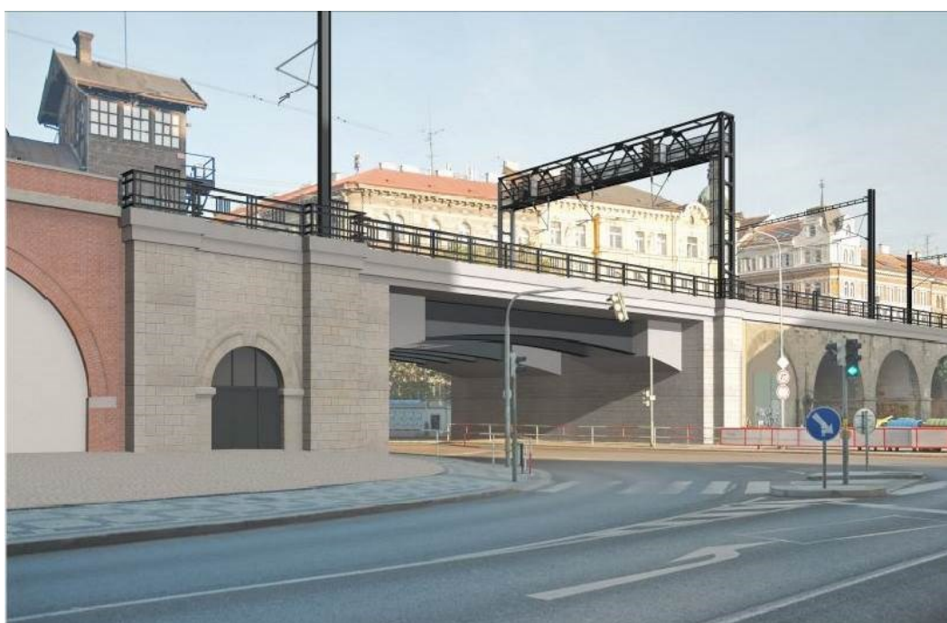
20) Stav po rekonstrukci, z ulice Prvního pluku
