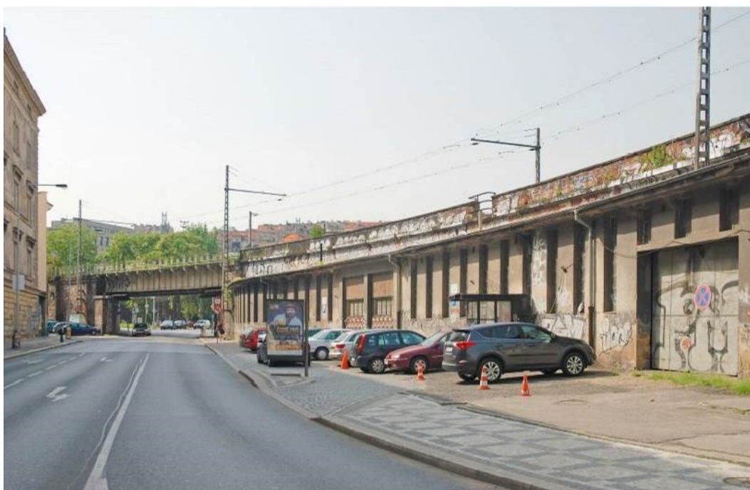
15) Stav před rekonstrukcí, ulice Prvního pluku
