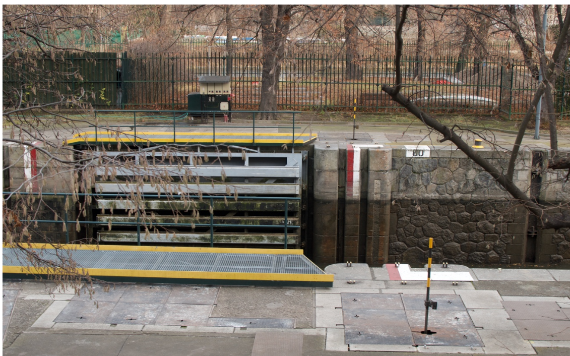
Obr. č. 19 Vrata v plavební komoře (Vlastní archiv, 2017)
