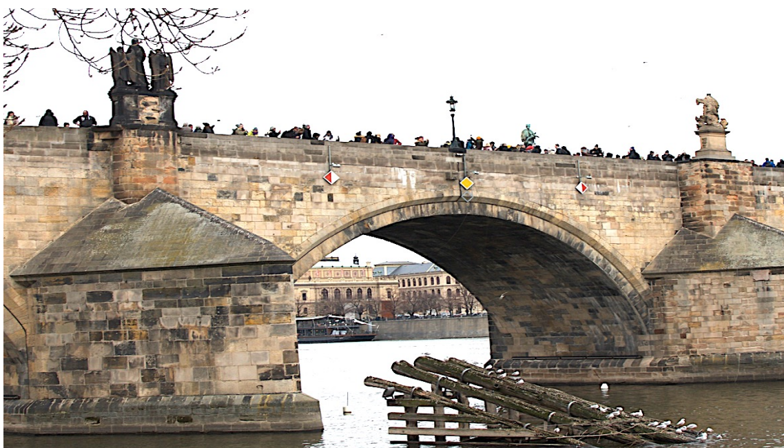
Obr. č. 13 Zákaz plavby mimo vyznačený prostor (proplouvat lze pouze v rozmezí bílých trojúhelníků), Doporučené proplouvání v obou směrech značí žlutý kosočtverec. (Vlastní archiv, 2017)
