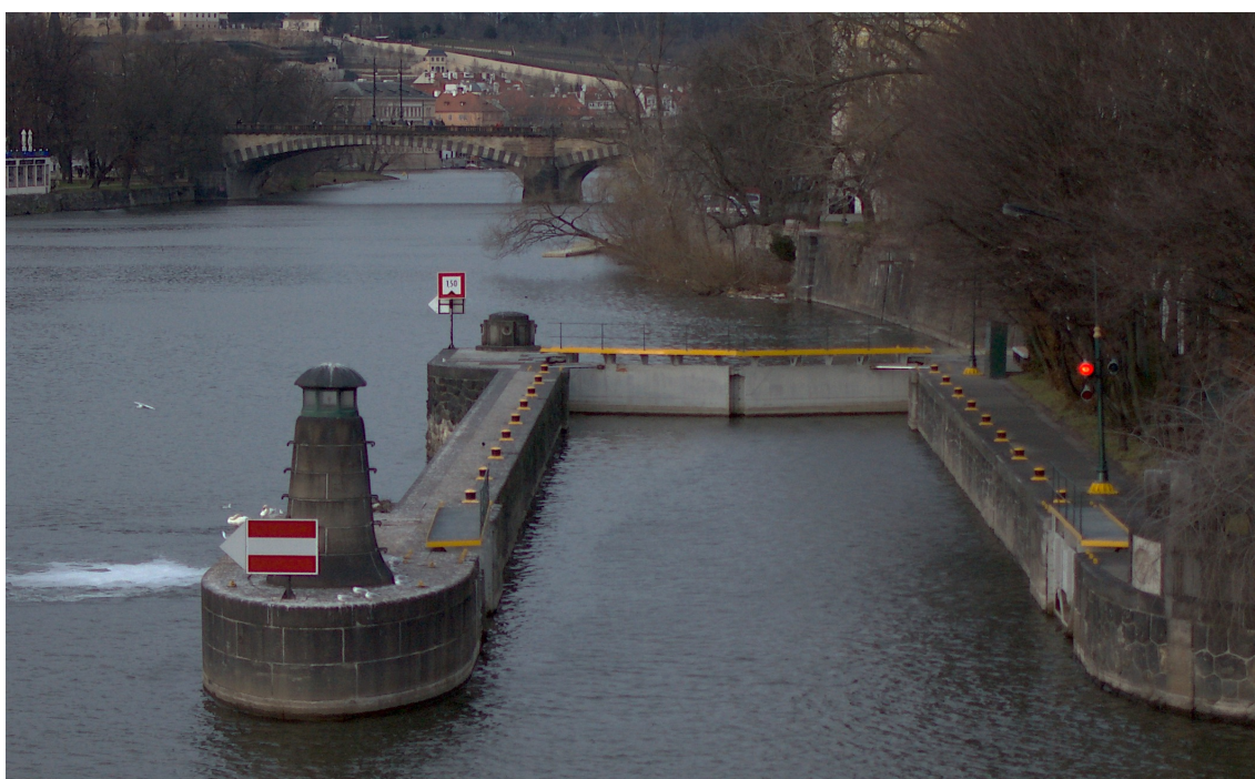
Obr. č. 18 označení značení zprava, zákaz proplutí vlevo – Hloubka: 1,50, značka na konci plavební komory – Optická signalizace, červená, zákaz vplutí – semafor (Vlastní archiv, 2017)
