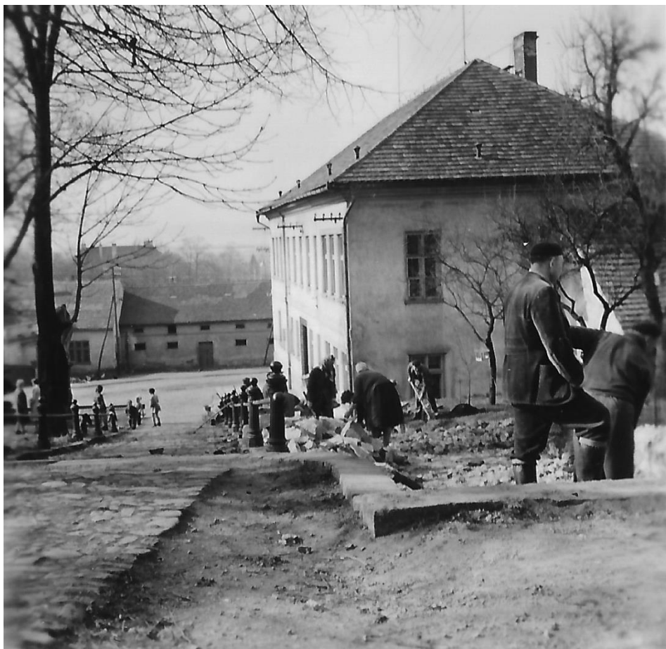
Brigáda na stavbě Víseckého náměstí 1950
