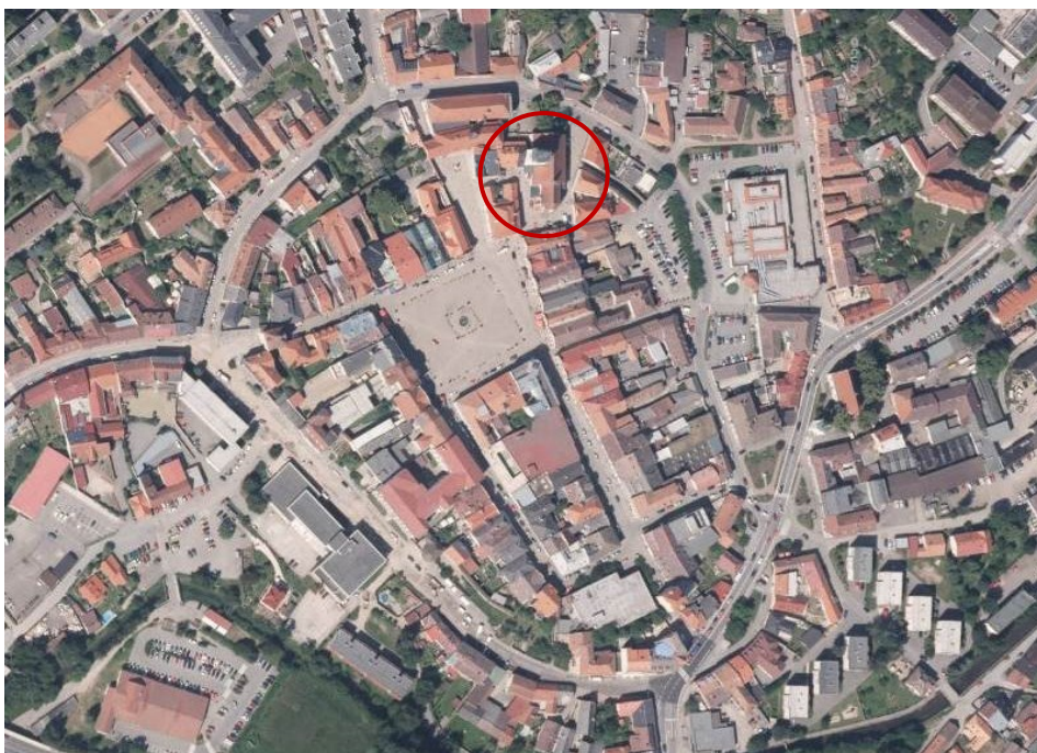
1. Pelhřimov , kostel sv. Bartoloměje, poloha kostela v rámci historického jádra města, nynější stav
