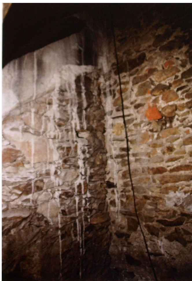
14. Pelhřimov , kostel sv. Bartoloměje, detail styku vých. průčelí věže a jižní zdi hl. lodi
