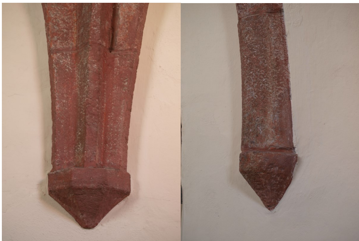
16. Pelhřimov , kostel sv. Bartoloměje, konzoly klenby (střední a pův. nárožní) severní lodi
