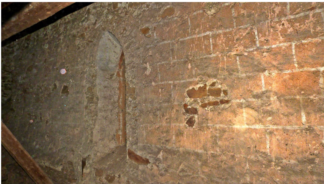
10. Pelhřimov , kostel sv. Bartoloměje, gotická omítka pod krovem severní boční lodi, před 1420
