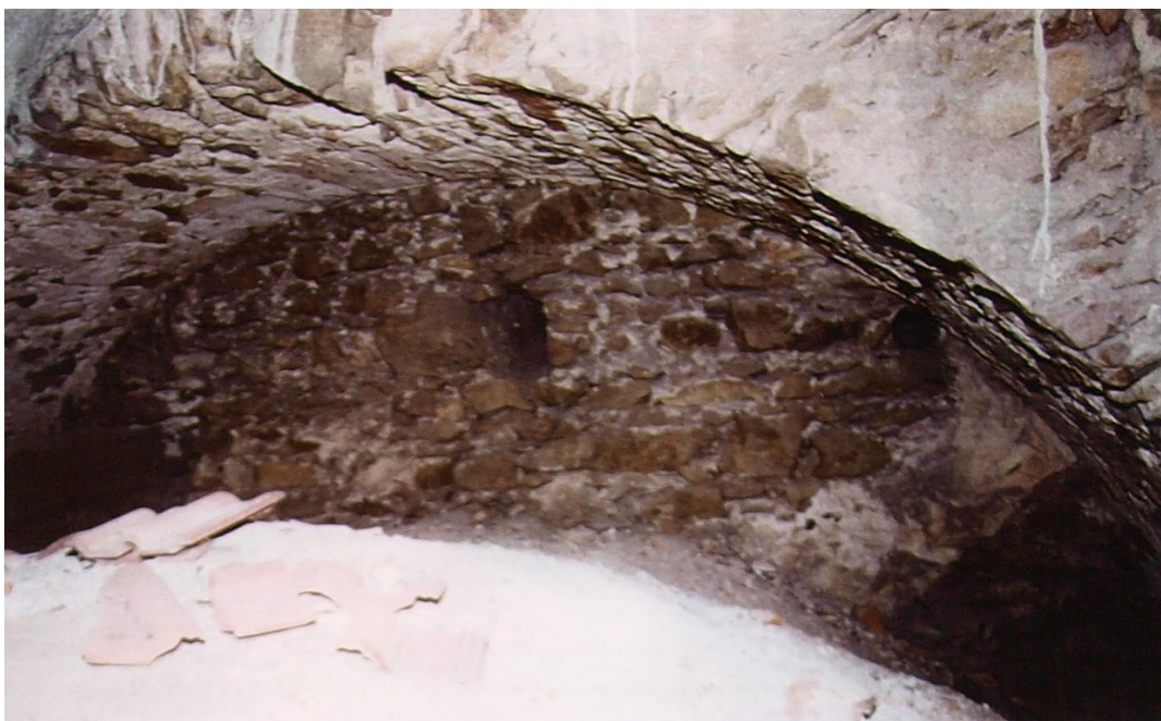
13. Pelhřimov , kostel sv. Bartoloměje, odlehčovací oblouk ve zdivu východního průčelí věže
