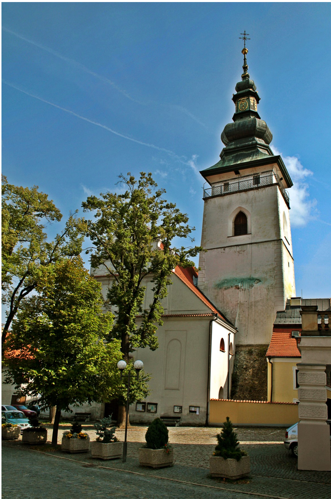
4. Pelhřimov, kostel sv. Bartoloměje, pohled od západu
