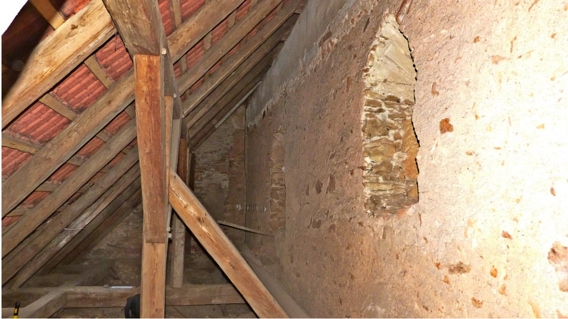
6. Pelhřimov , kostel sv. Bartoloměje, podkroví jižní boční lodi. Stěna hlavní lodi s dvěma prolomenými okny původní baziliky.
