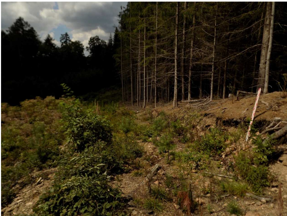
Obrázek 109: Červenice – porušení vnějšího příkopu hradního jádra. Foceno z východu.
