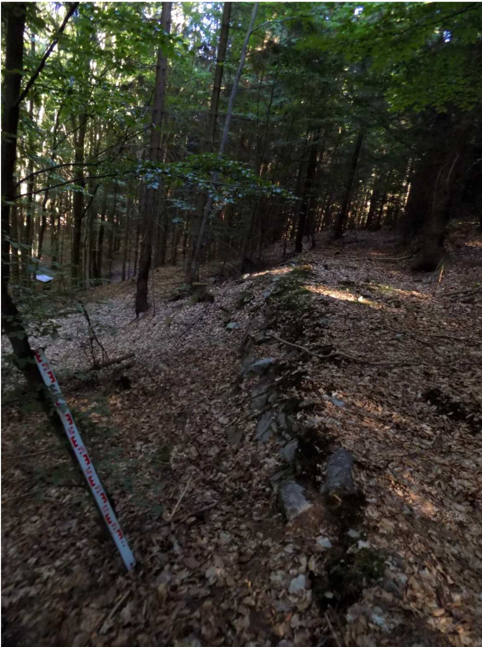
Obrázek 35: Hengst. Objekt č. 3 – úsek komunikace při sedmé serpentíně (ve směru od hradu). Foceno ze severozápadu.
