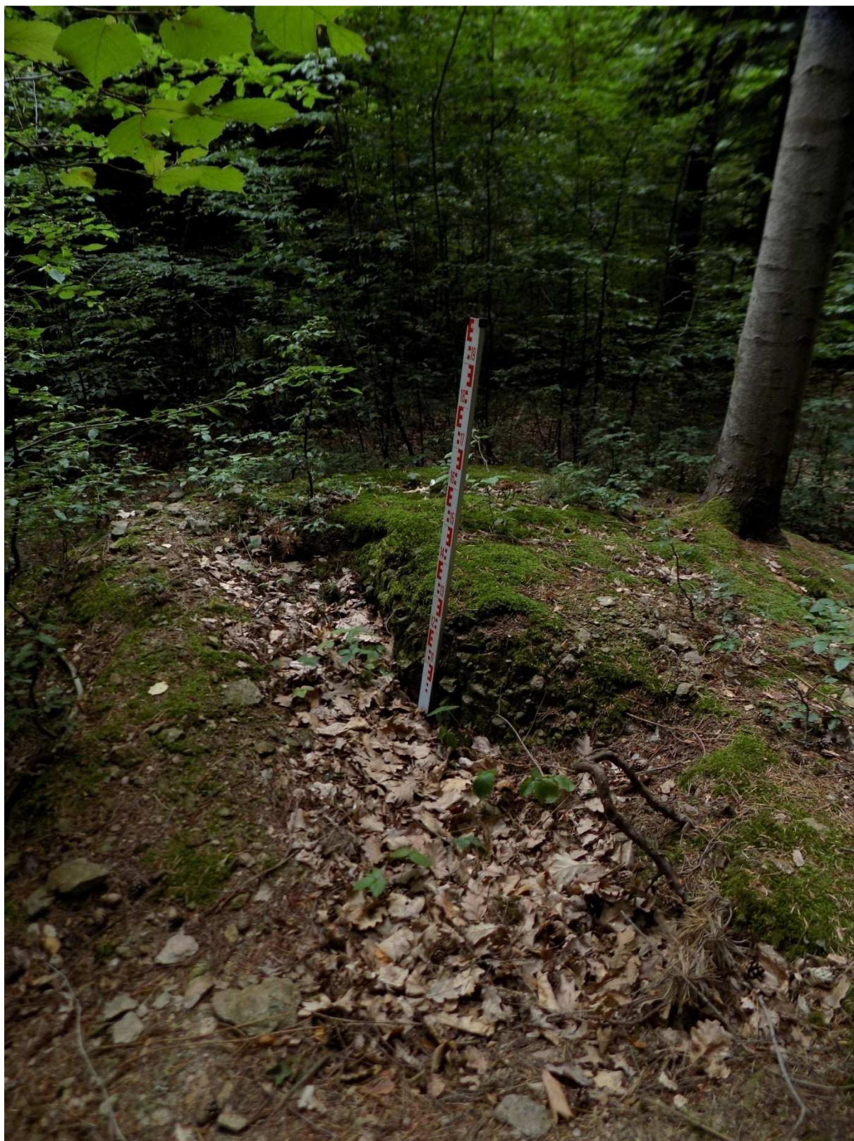
Obrázek 113: Červenice – narušení valu vnějšího opevnění hradu. Foceno od jihovýchodu.
