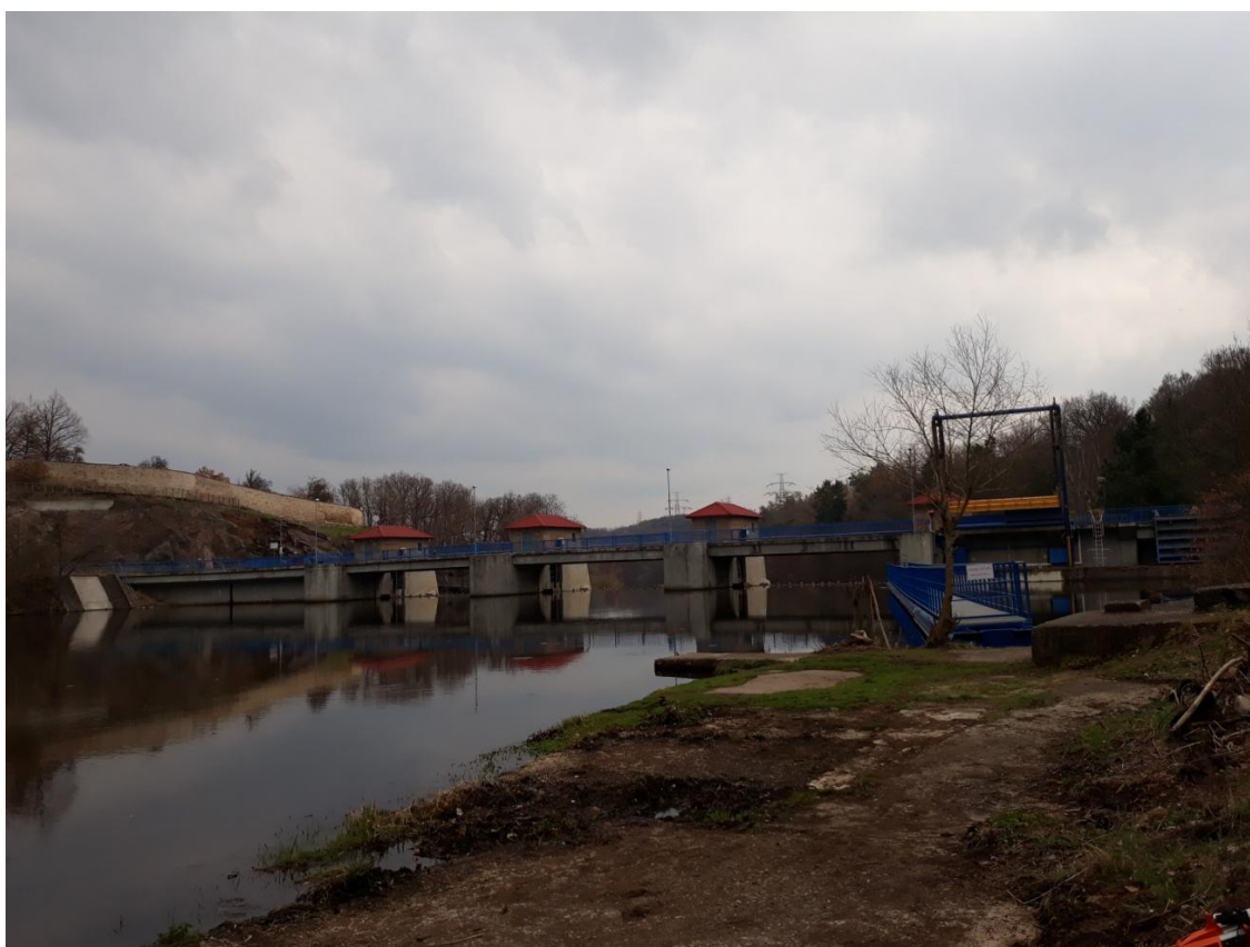
Obr. 9: Hráz nádrže Kadaň
