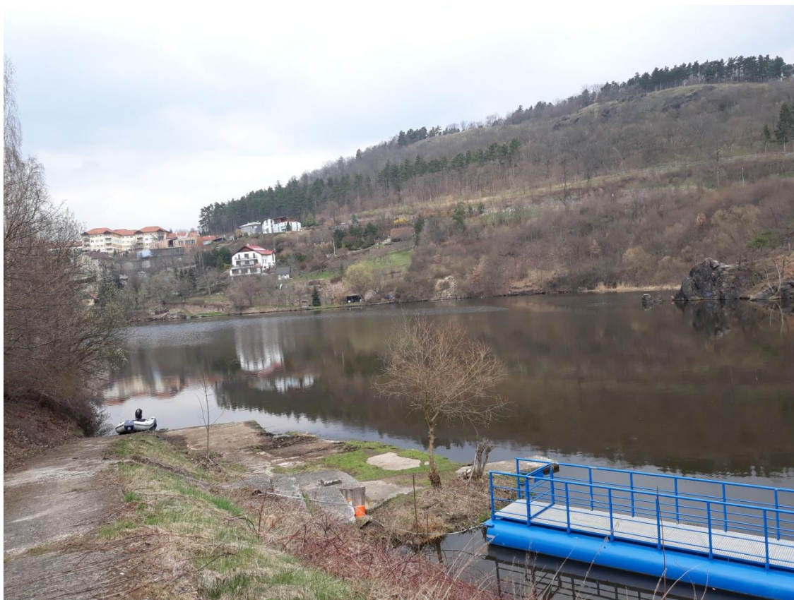
Obr. 10: Pohled směrem od hráze
