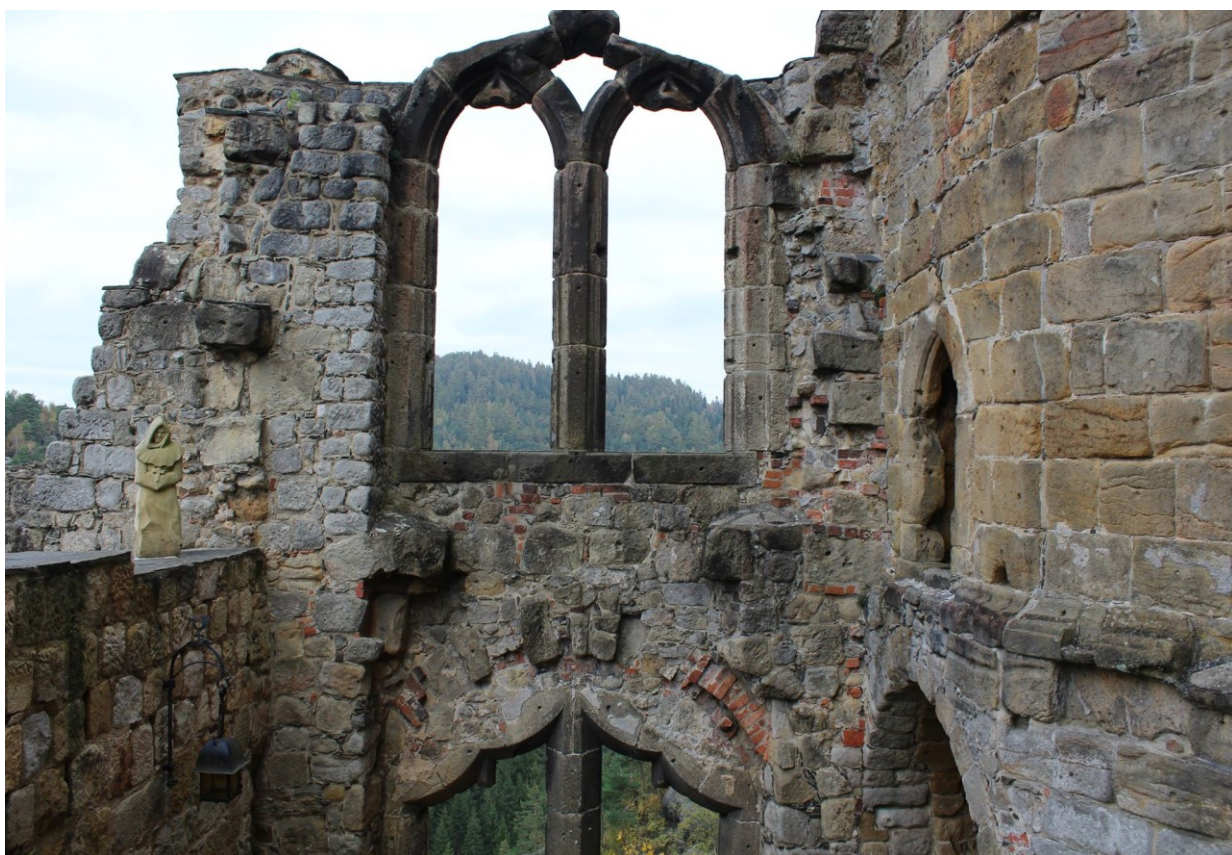
Zříceniny ojvínského komplexu, současný stav
