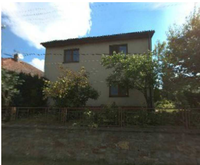
Obrázek 7 Dům čp. 126 dnes. Původně přízemní dům získal přestavbou v 70. letech 20. století první patro.
