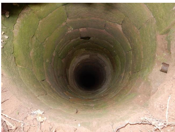
Obr. 9: Studny v obci jsou až 20 m hluboké Zdroj: Jakub Turek
