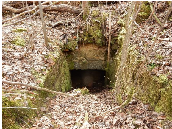
Obr. 6: Vstup do sklepa Zdroj: Jakub Turek
