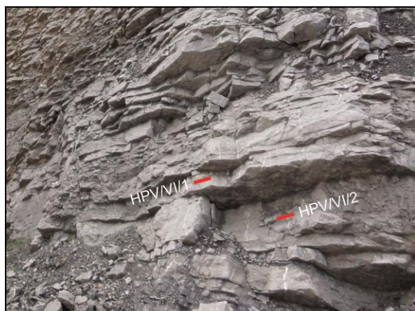
Obr. 3.20. Sled šedivých deskovitých zlíchovských vápenců v hlavní lomové stěně v jižní části ložiska s vyznačeným místem odběru vzorků HPV/VI/1 a HPV/VI/2.
