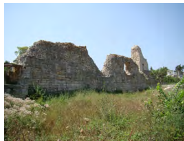
Pl. 9/4: Hradby Chersonésu nedaleko Zenónovy věže (foto autorky).
