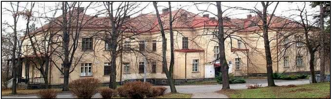
Budova Léčebny dlouhodobě nemocných v Psychiatrické léčebně v Bohonicích.
