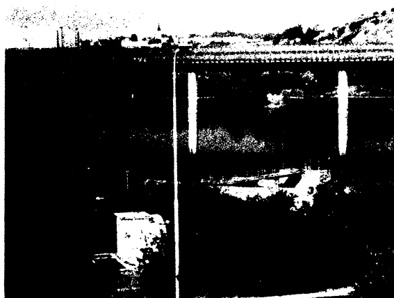
Obr. 5 Tubus metra v Nových Butovicích
