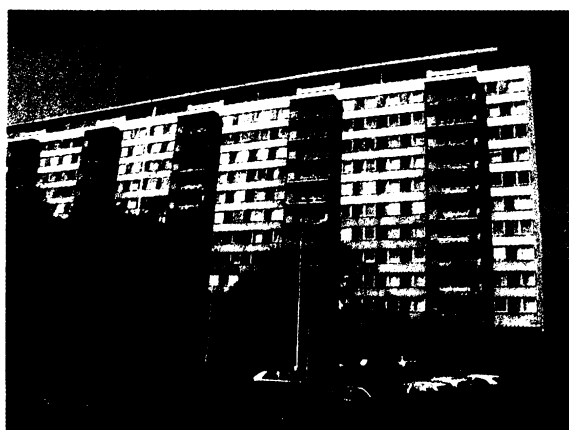
Obr. 22 Dům v Ďáblicích před opravou
