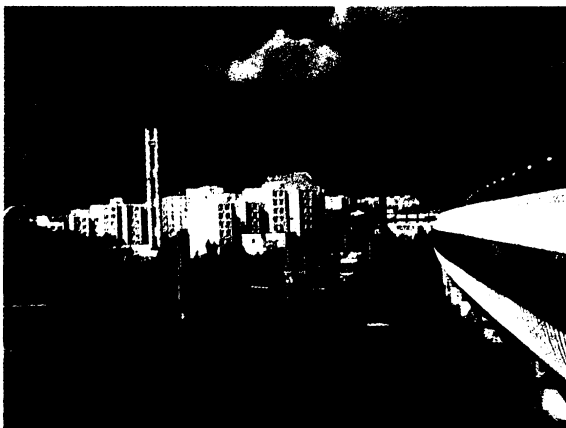
Obr.4 Tubus metra na Černém Mostě
