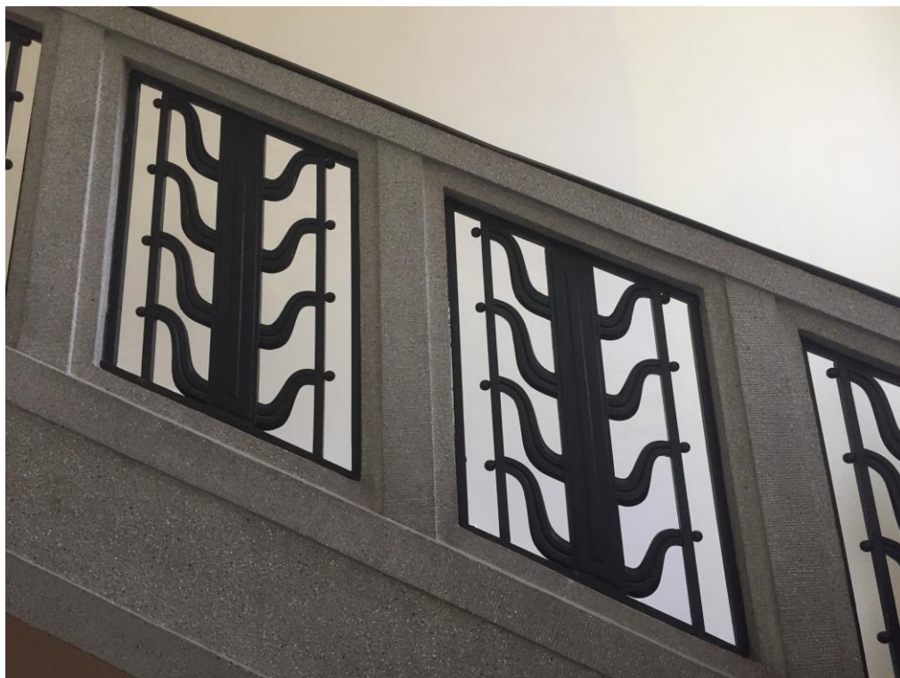
36. Detail schodiště v radiotelegrafní stanici v Poděbradech
