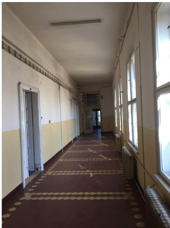
46. Dnešní podoba chodby v ústředně
