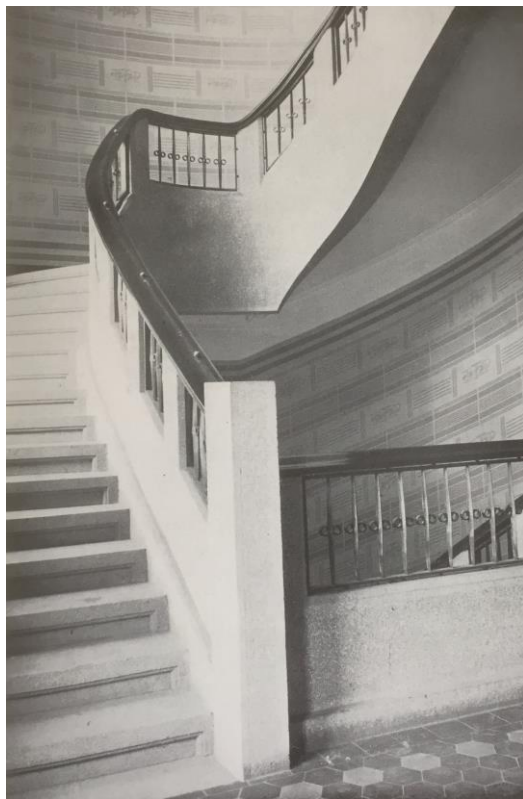
14. Detail schodiště telegrafní ústředny se sgrafitovou výzdobou, 1929
