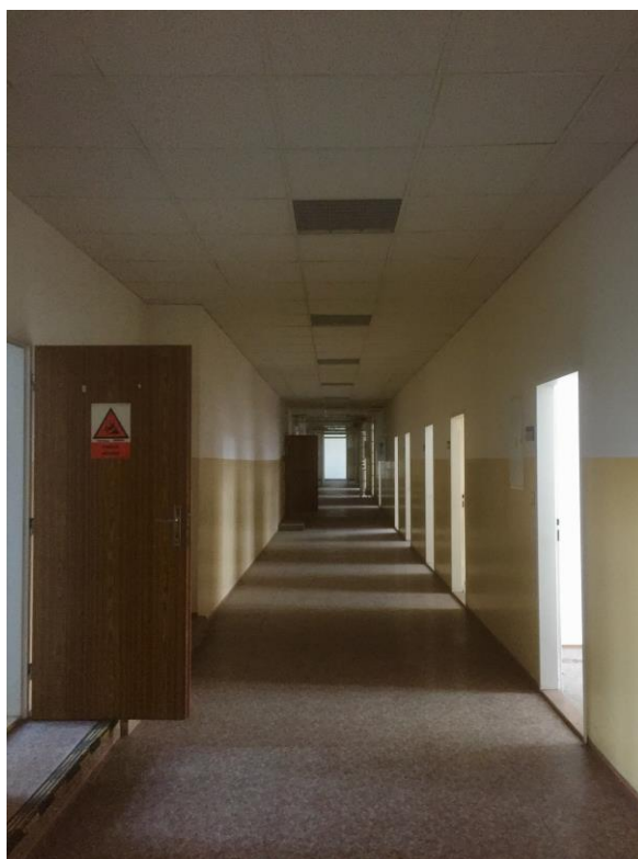
47. Dnešní podoba chodby v ústředně
