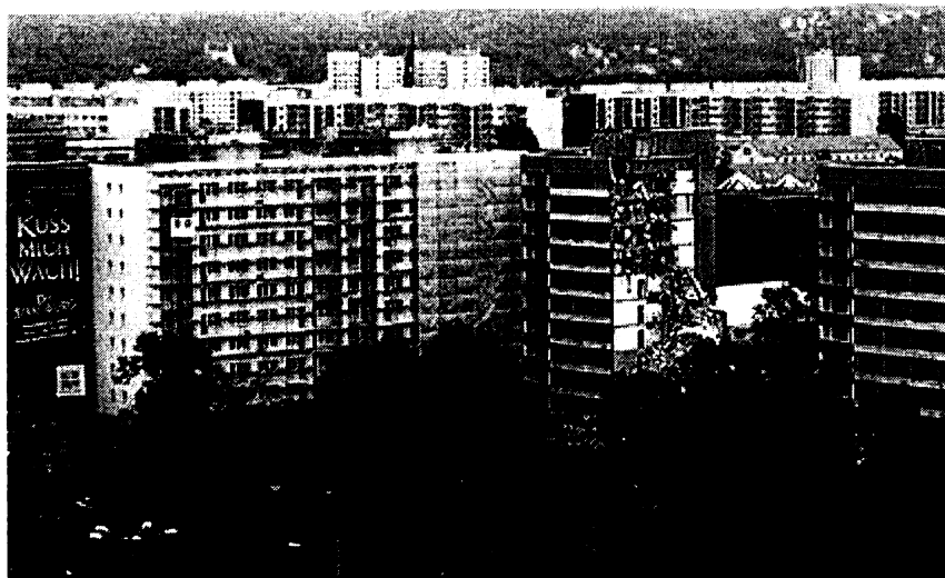
Obr.3.3.2.1: Bytový fond v Drážďanech
