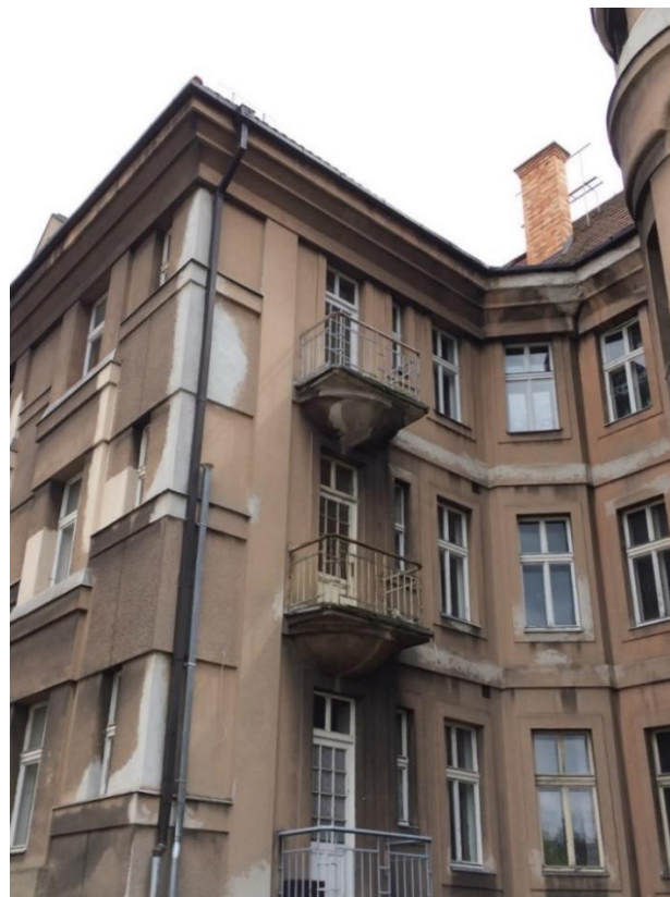
19. Plzeň, dům na Klatovské třídě 721/110 s bytem rodiny Semlerových, neznámý autor/ Adolf Loos (?) – Heinrich Kulka, 1923/ 1932–1934, pohled ze dvora, východní boční křídlo, 2017
