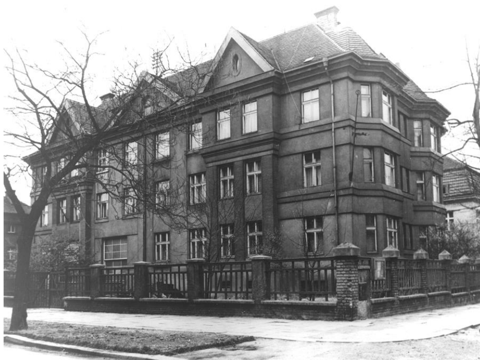
5. Plzeň, dům na Klatovské třídě 721/ 110 s bytem rodiny Semlerových, neznámý autor/ Adolf Loos (?) – Heinrich Kulka, 1923/ 1932–1934, pohled z jihovýchodu
