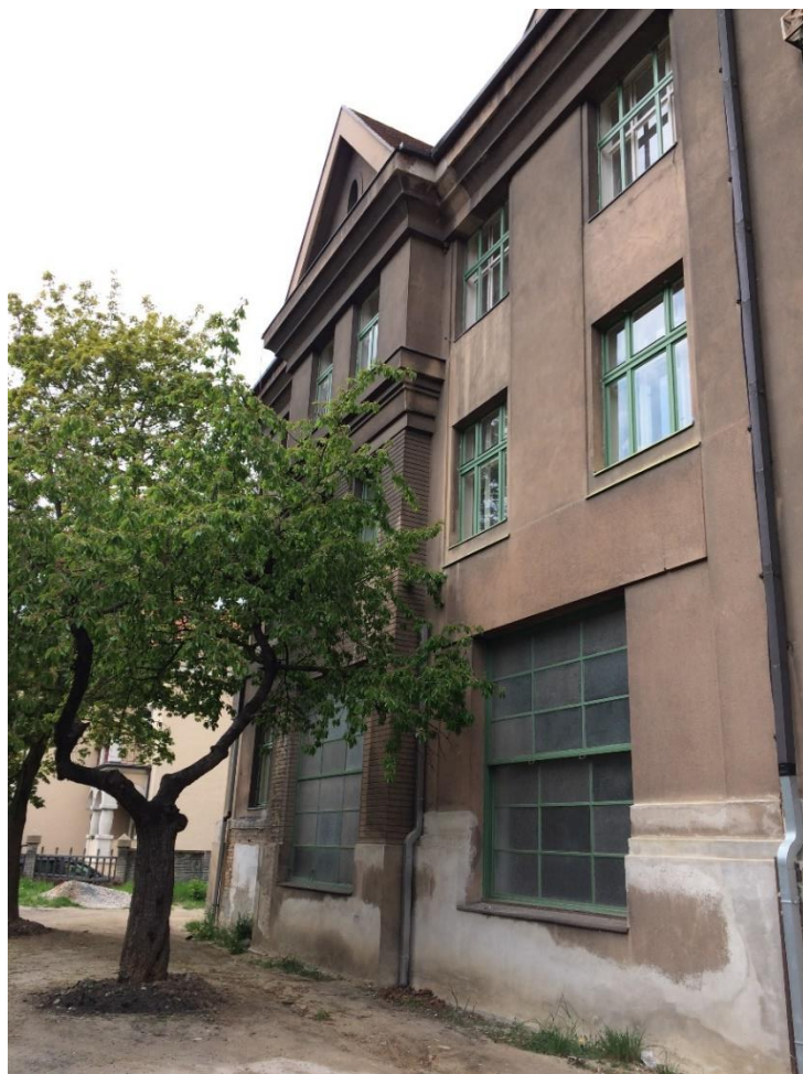
26. Plzeň, dům na Klatovské třídě 721/ 110 s bytem rodiny Semlerových, neznámý autor/ Adolf Loos (?) – Heinrich Kulka, 1923/ 1933–1934, jižní průčelí, pohled na okna obytné haly, 2017
