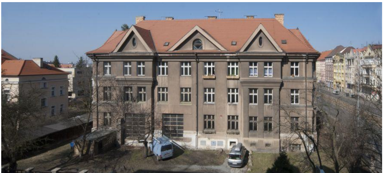
25. Plzeň, dům na Klatovské třídě 721/ 110 s bytem rodiny Semlerových, neznámý autor/ Adolf Loos (?) – Heinrich Kulka, 1923/ 1933–1934, pohled z jihu, 2017
