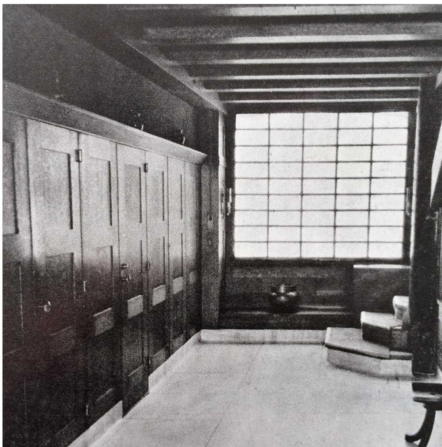
65. Adolf Loos, Vila Karma, Montreaux, 1903–1906, pohled na okno v šatně, třicátá léta 20. století
