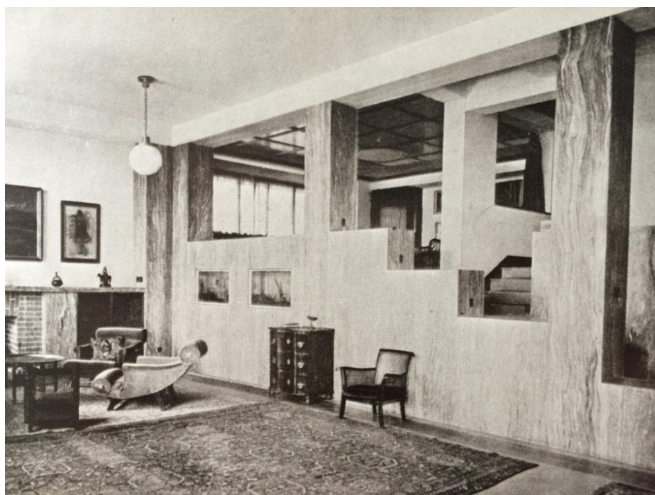
48. Adolf Loos, Müllerova vila, Praha, 1928–1930, obytná hala, pohled na jídelnu, třicátá léta 20. století
