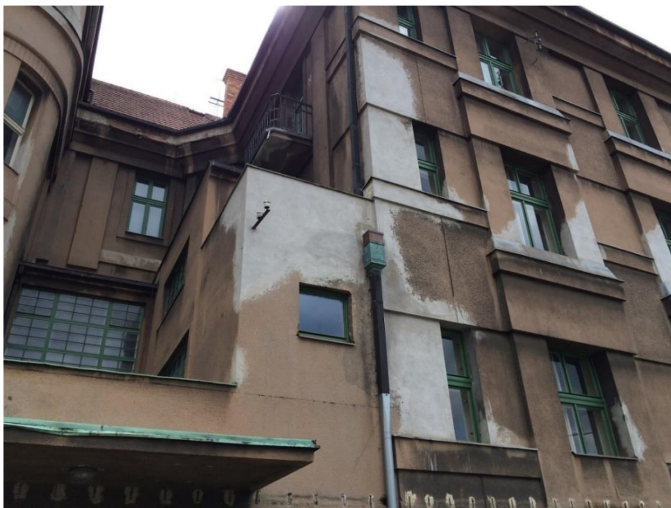
20. Plzeň, dům na Klatovské třídě 721/ 110 s bytem rodiny Semlerových, neznámý autor/ Adolf Loos (?) – Heinrich Kulka, 1923/ 1933–1934, pohled ze dvora, zpadní boční křídlo s přístavbou, 2017
