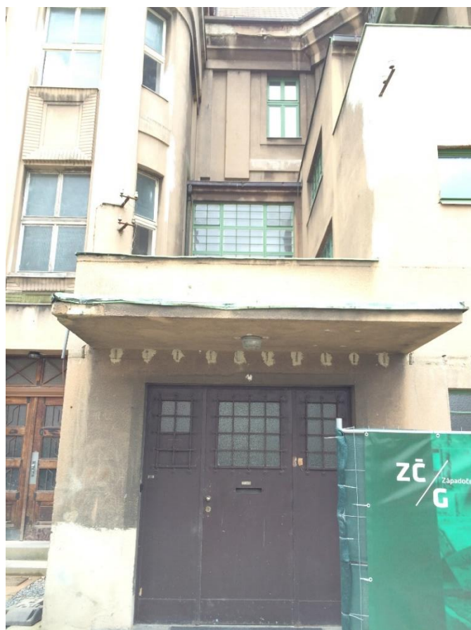
22. Plzeň, dům na Klatovské třídě 721/ 110 s bytem rodiny Semlerových, neznámý autor/ Adolf Loos (?) – Heinrich Kulka, 1923/ 1933–1934, přístavba se vstupním vestibulem, 2017
