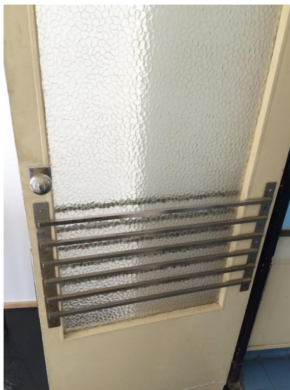
75. Adolf Loos (?) – Heinrich Kulka, byt rodiny Semlerových, Plzeň, 1932–1934, servisní zázemí při kuchyni, původní dveře s mosazným chráničem skla, 2017
