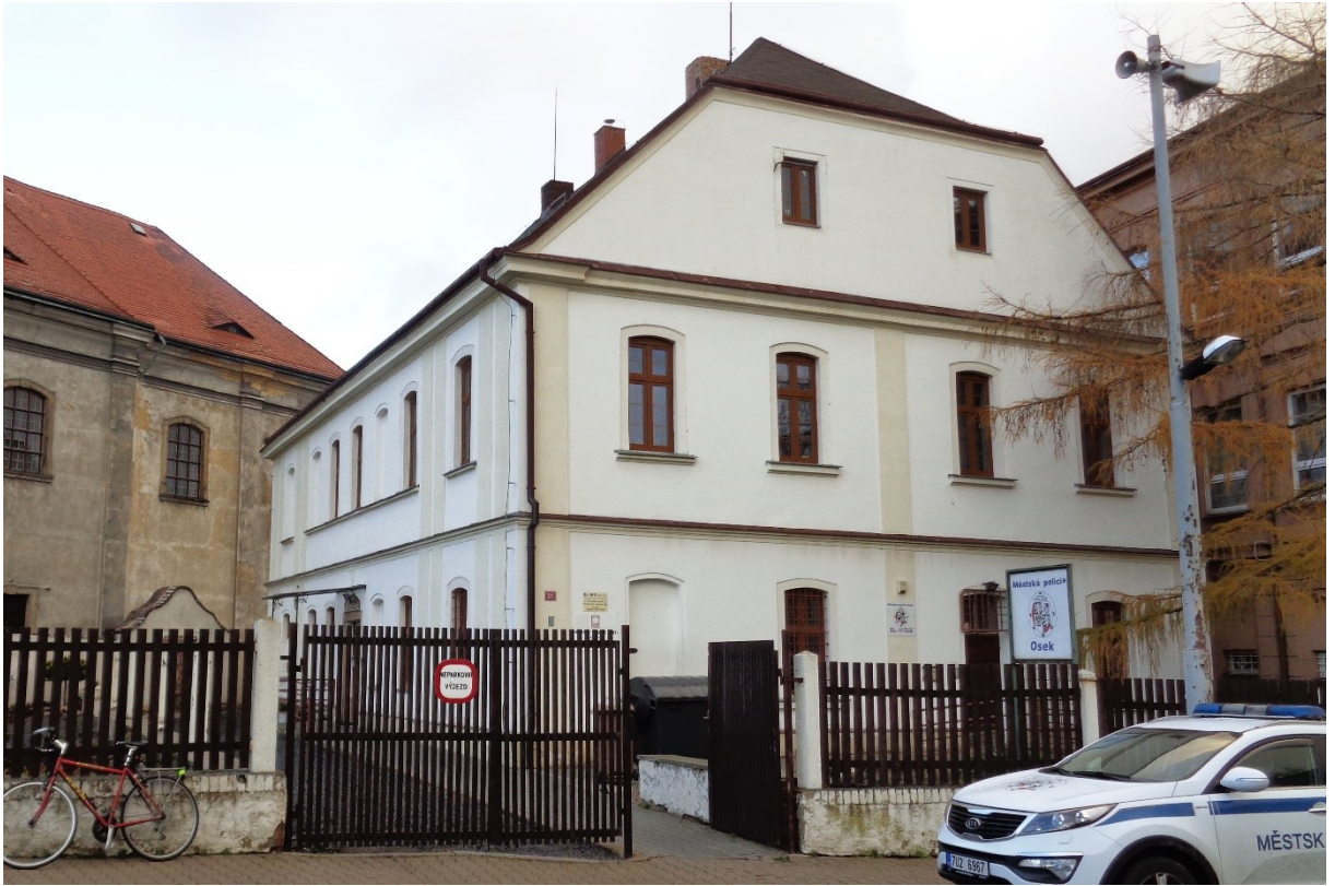
Obrázek 15: bývalá budova fary v Oseku, 2017, autor: Miroslav Tyl.
