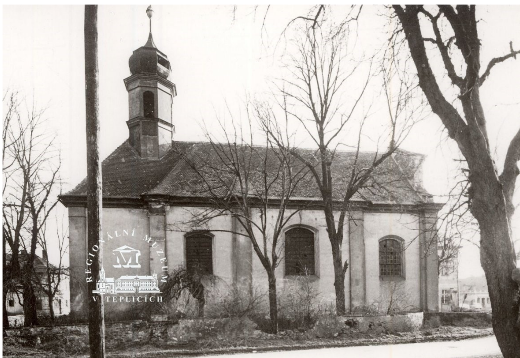
Obrázek 7: Farní kostel v Jenišově Újezdu, 1967, zdroj: SOkA Teplice, dostupné na: http://znicenekostely.cz/ .
