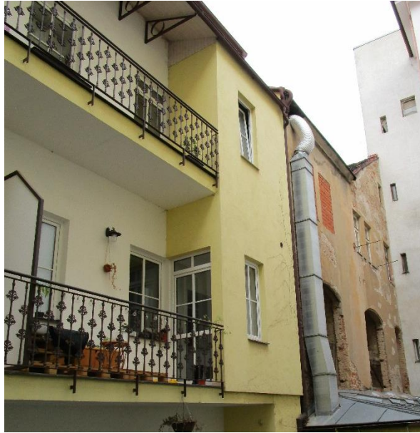
44. Žižkov , Vlkova, pavlačový dům, zrekonštruovaná pavlač
