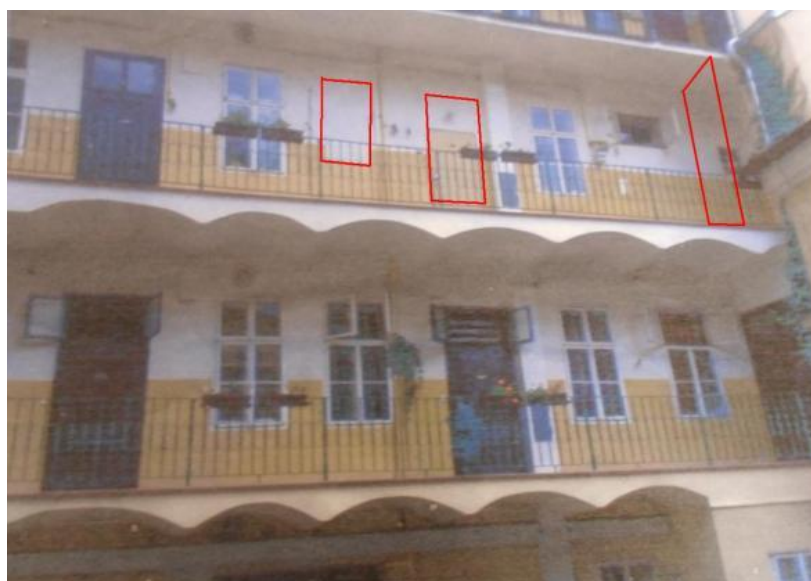
8. Žižkov , Vlkova 20, č. p. 441, Vlkova 20, před rekonstrukcí
