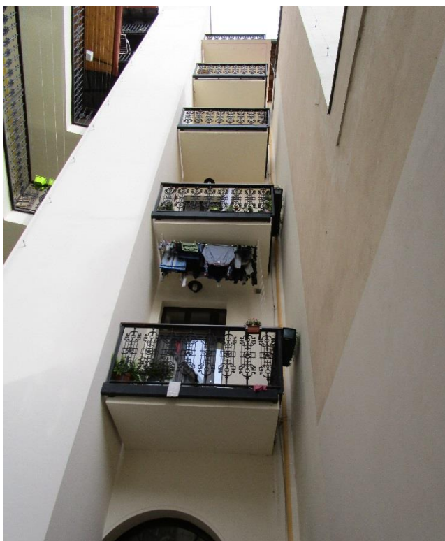
36. Žižkov , Prokopovo náměstí 220/9, pavlačový dům, pavlač rozdělená nově postavenou výtahovou šachtou
