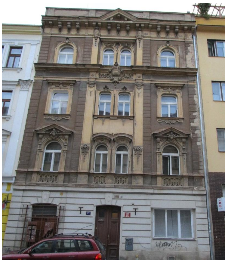
10. Žižkov , průčelí domu Vlkova ulice čp. 366
