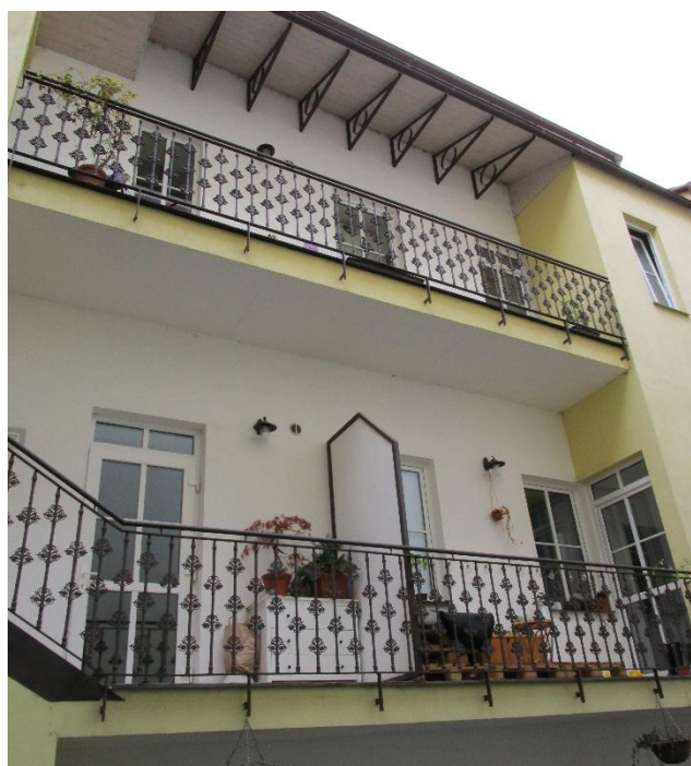
43. Žižkov , Vlčkova, pavlačový dům, zrekonstruovaná pavlač
