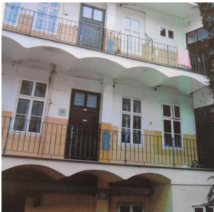
9. Žižkov , Vlkova 20, č. p. 441, Vlkova 20, po rekonstrukci
