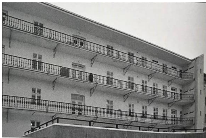
28. Žižkov , rok 1873, pavlačový dům s dvojicí záchodů na konci každé pavlače, vodovodní niky s výlevkami na každém patře vedle vyústění schodů
