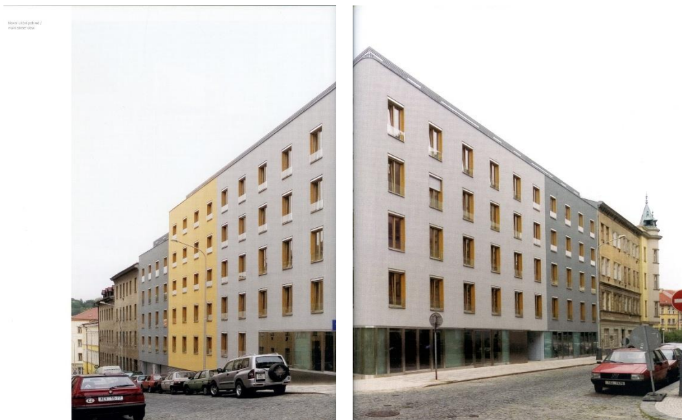
18. Žižkov, Polyfunkční dům Eucon, pohled z ulice Štítného čp. 202
