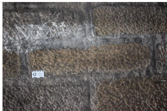
Obrázek 38: Zdivo tunelu (Černý T.)
