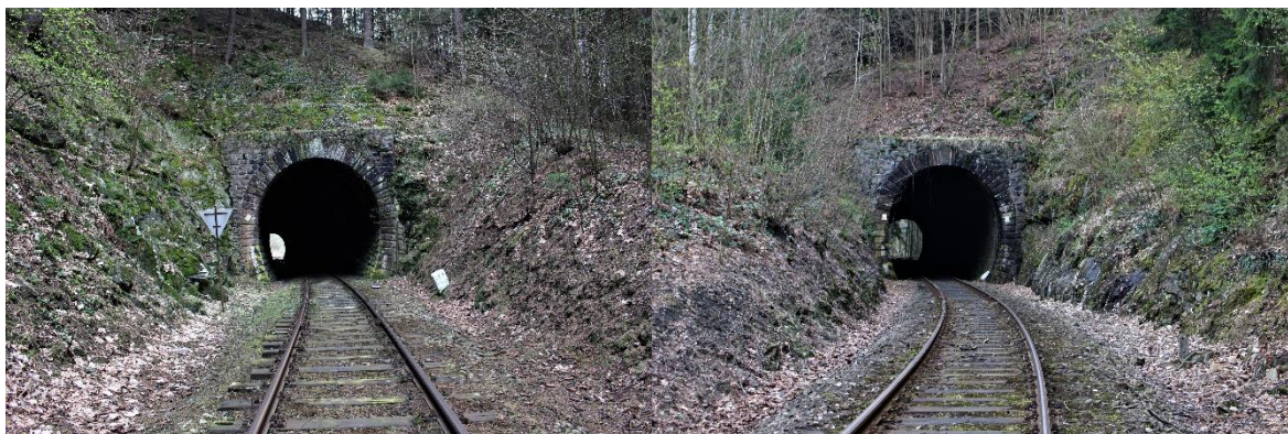
Obrázek 74: Východní portál Rátajského tunelu I (Černý T.)
