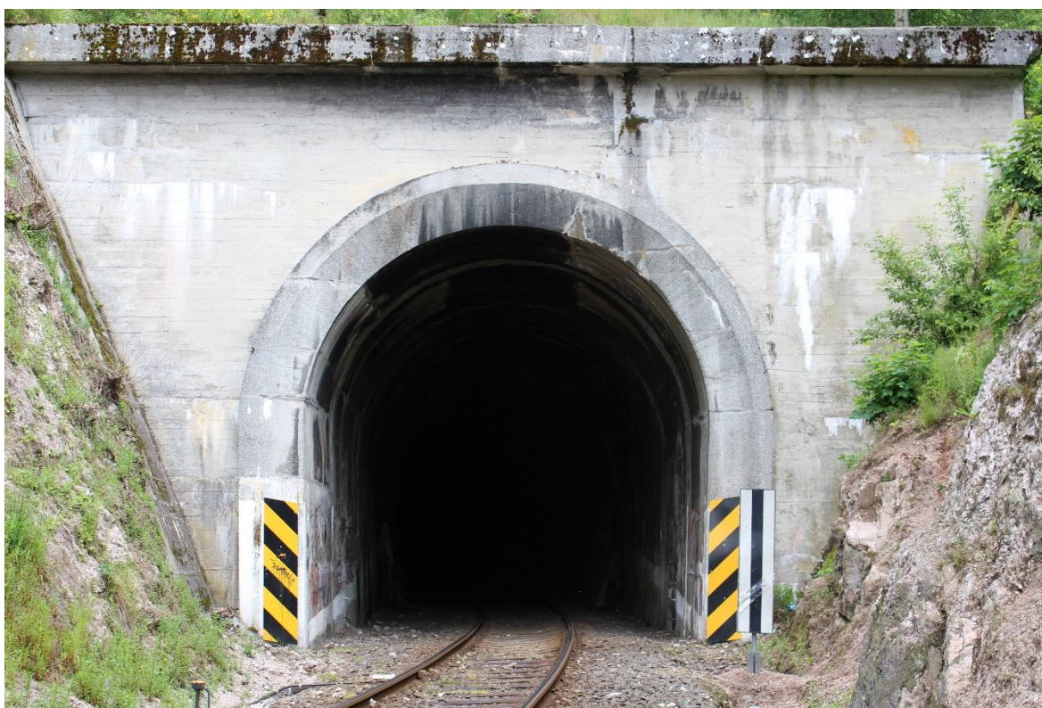
Obrázek 23: Detail jižního portálu Nejdeckého tunelu (Černý T.)
