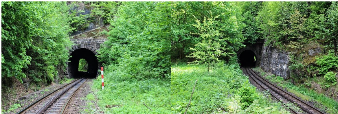
Obrázek 119: Jižní portál Žďárského tunelu (Černý T.)
