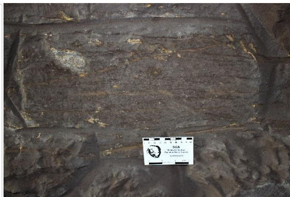
Obrázek 63: Zdivo tunelu (Černý T.)
