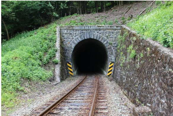
Obrázek 11: Severovýchodní portál Bečovského tunelu (Černý T.)
