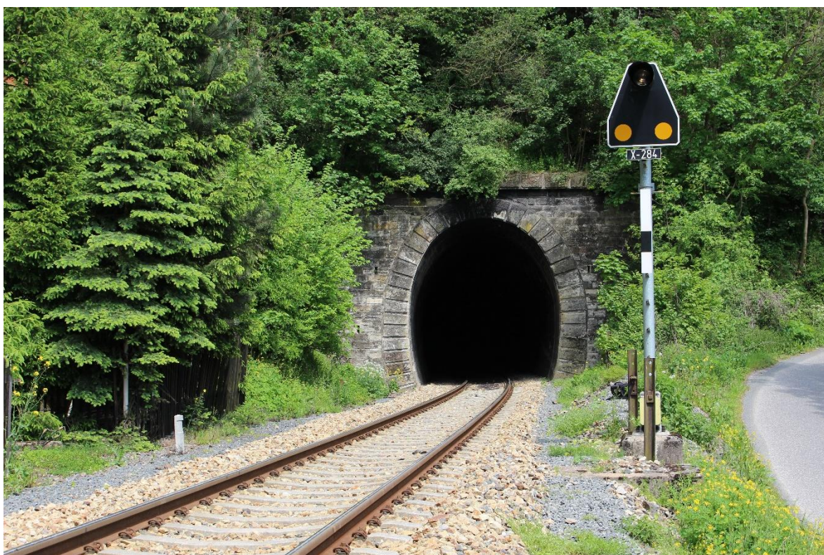
Obrázek 42: Detail jižního portálu tunelu Pod Královskou pěšinkou (Černý T.)
