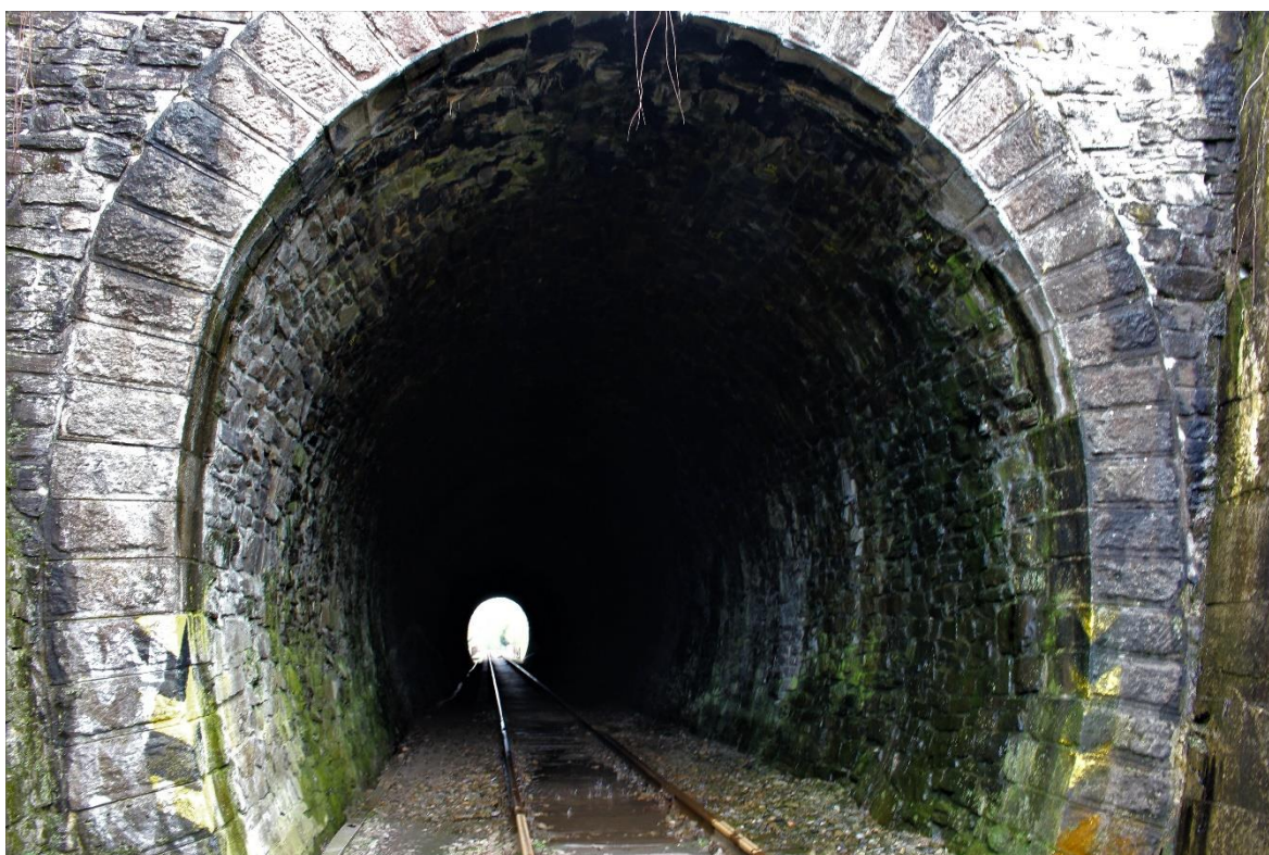
Obrázek 86: Detail severního portálu Vlastějovického tunelu (Černý T.)
