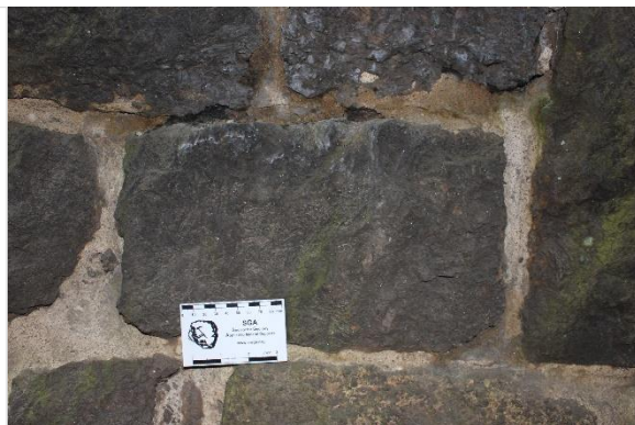
Obrázek 112: Zdivo tunelu (Černý T.)
