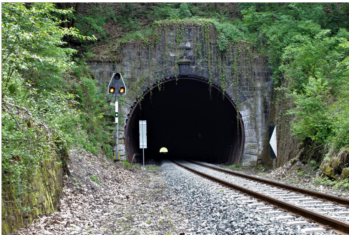
Obrázek 57: Detail východního portálu Rynholeckého tunelu (Černý T.)
