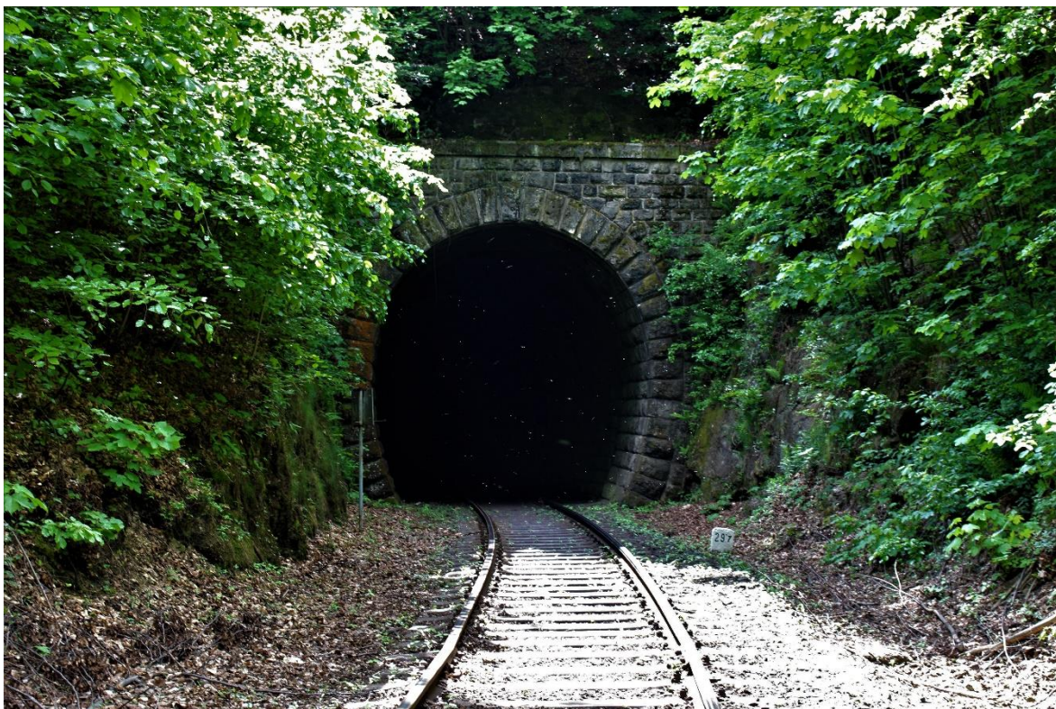
Obrázek 126: Detail severního portálu Desenského tunelu (Černý T.)
