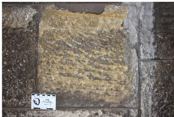
Obrázek 53: Zdivo tunelu (Černý T.)
