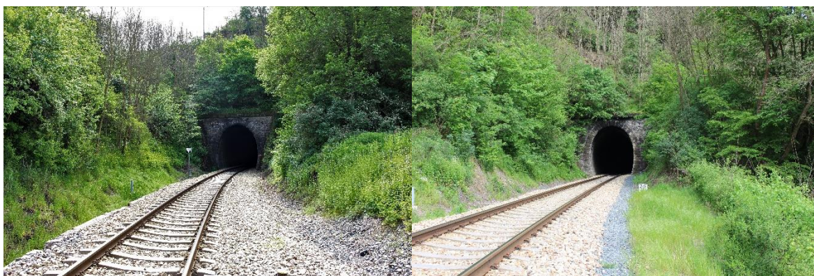
Obrázek 45: Severní portál tunelu Pod Basou (Černý T.)
