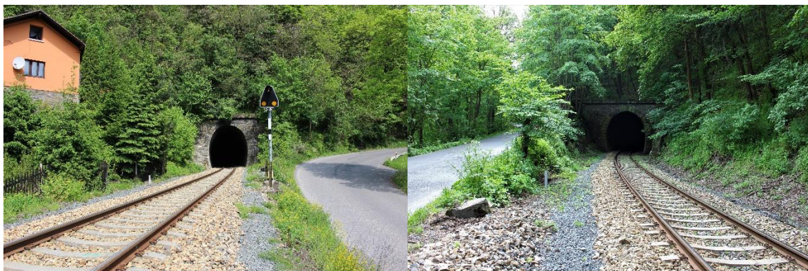
Obrázek 40: Jižní portál tunelu Pod Královskou pěšinkou (Černý T.)
