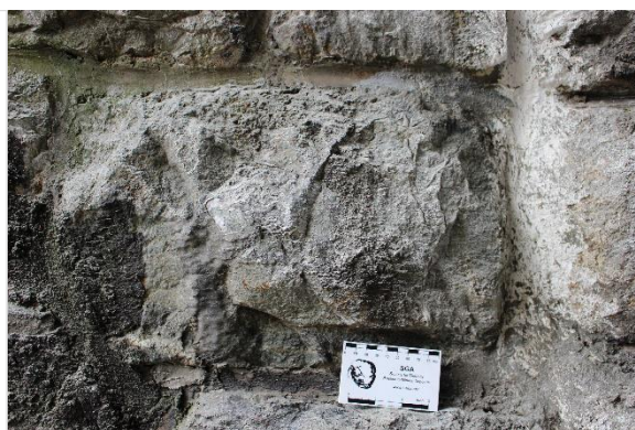
Obrázek 95: Zdivo tunelu (Černý T.)
