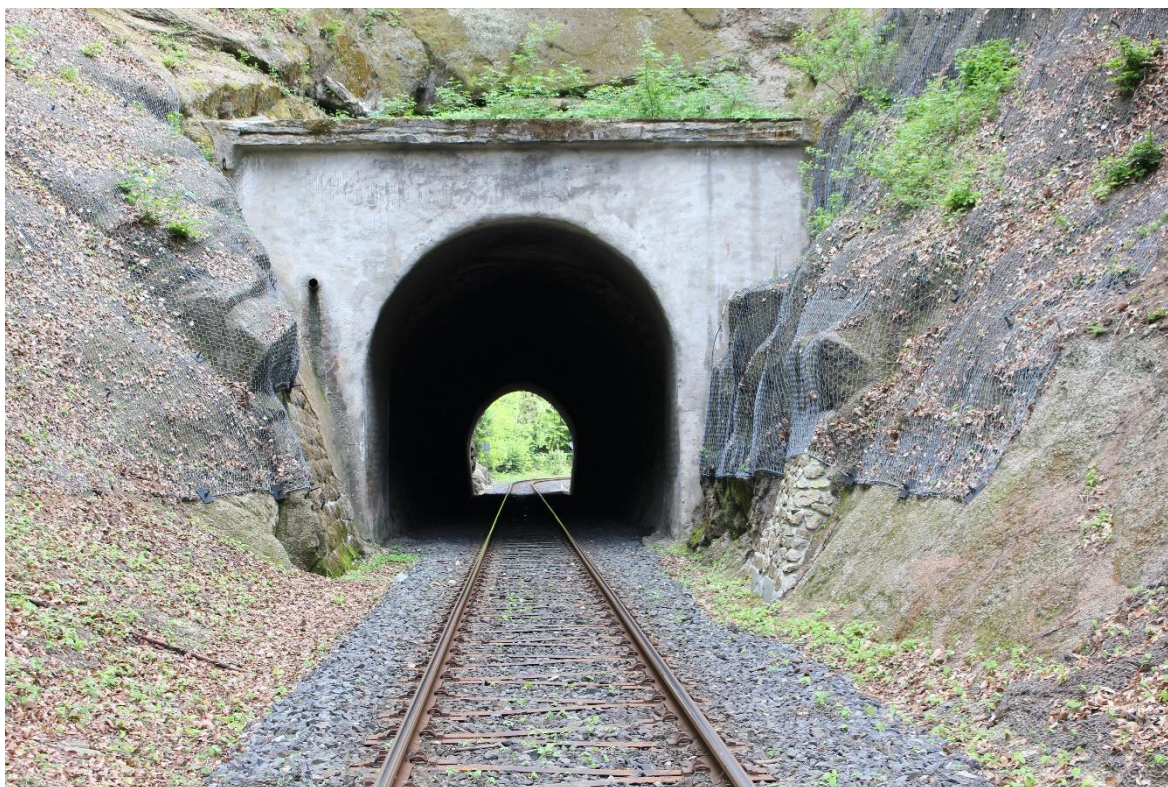
Obrázek 106: Detail severního portálu Prosečského tunelu (Černý T.)
