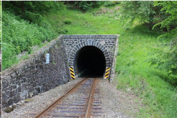
Obrázek 12: Jižní portál Bečovského tunelu (Černý T.)
