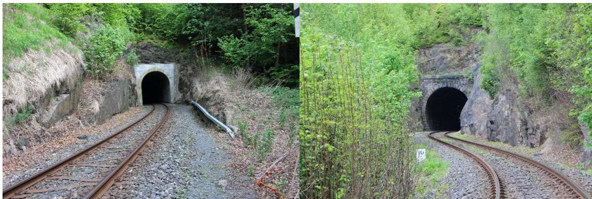
Obrázek 114: Západní portál Hornotanvaldského tunelu (Černý T.)
