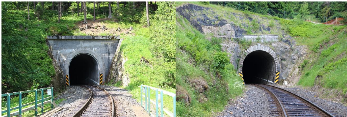
Obrázek 31: Severní portál Novohamerského tunelu (Černý T.)
