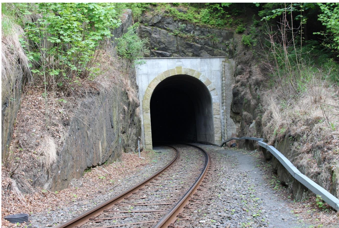
Obrázek 116: Detail západního portálu Hornotanvaldského tunelu (Černý T.)
