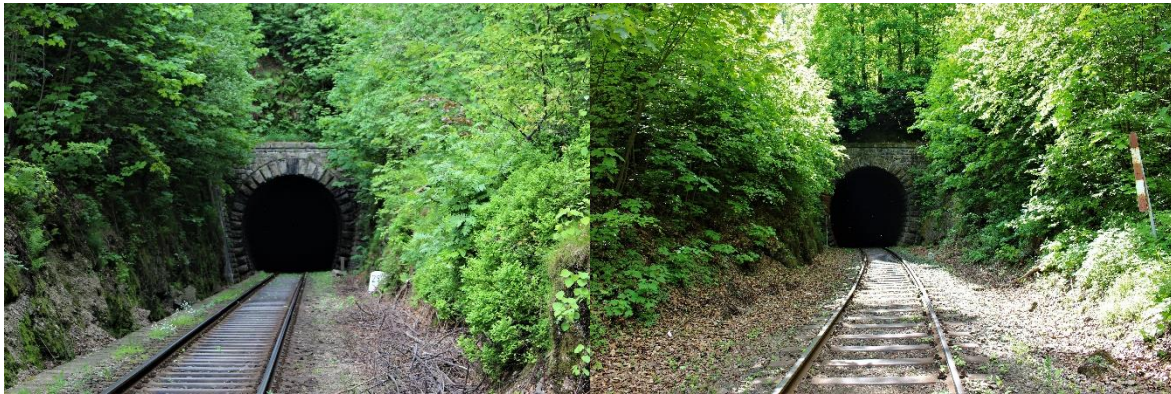
Obrázek 124: Jižní portál Desenského tunelu (Černý T.)
