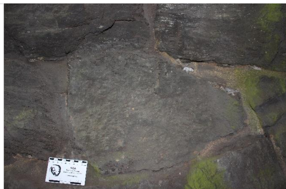
Obrázek 72: Zdivo tunelu 13 (Černý T.)
