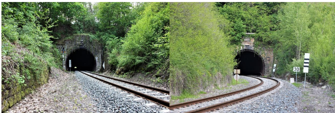
Obrázek 55: Východní portál Rynholeckého tunelu (Černý T.)
