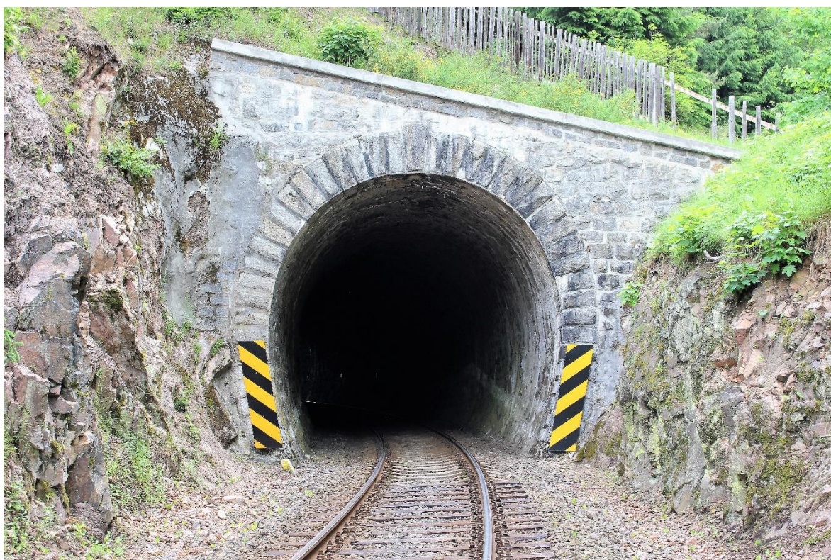
Obrázek 28: Detail jižního portálu Vysokopeckého tunelu (Černý T.)
