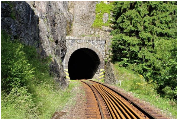
Obrázek 16: Jižní portál Dolnohamerského tunelu I (Černý T.)
