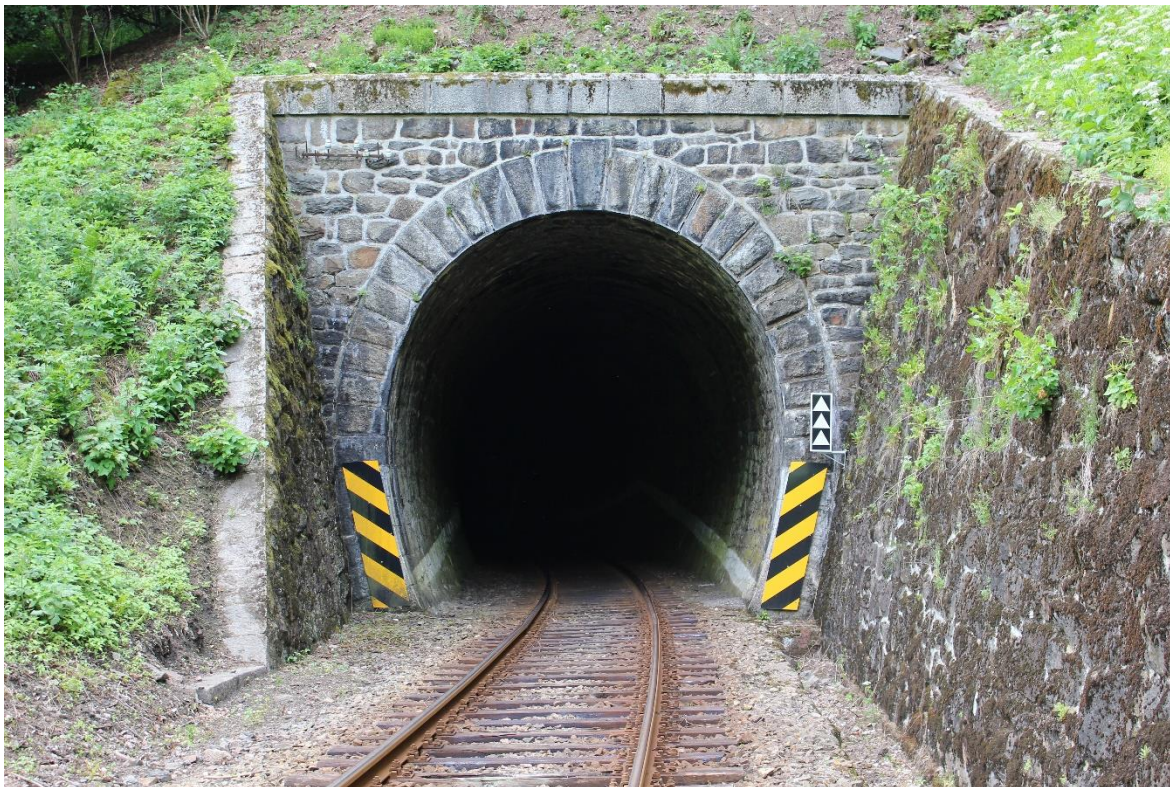
Obrázek 13: Detail severovýchodního portálu Bečovského tunelu (Černý T.)
