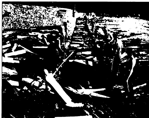
Obrázek 118: Voda zadržovaná v kluzách se vypouštěla za účelem plavení polenového dřeva v umělých kanálech či potocích (foto in ROUČKA 2006).
