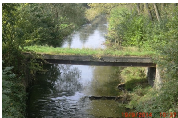
Obr. 25 Starý most přes řeku
