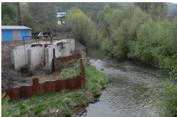
Obr. 16 Ohyb řeky se stavbou
