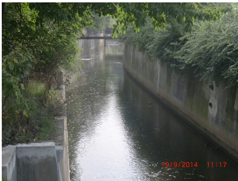
Obr. 2 Ukázka vybetonování koryta (řeka Bílina - intravilán města Bílina)
