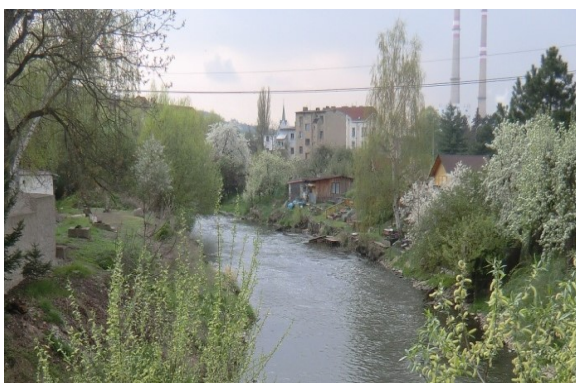
Obr. 18 Stavby v blízkosti koryta řeky
