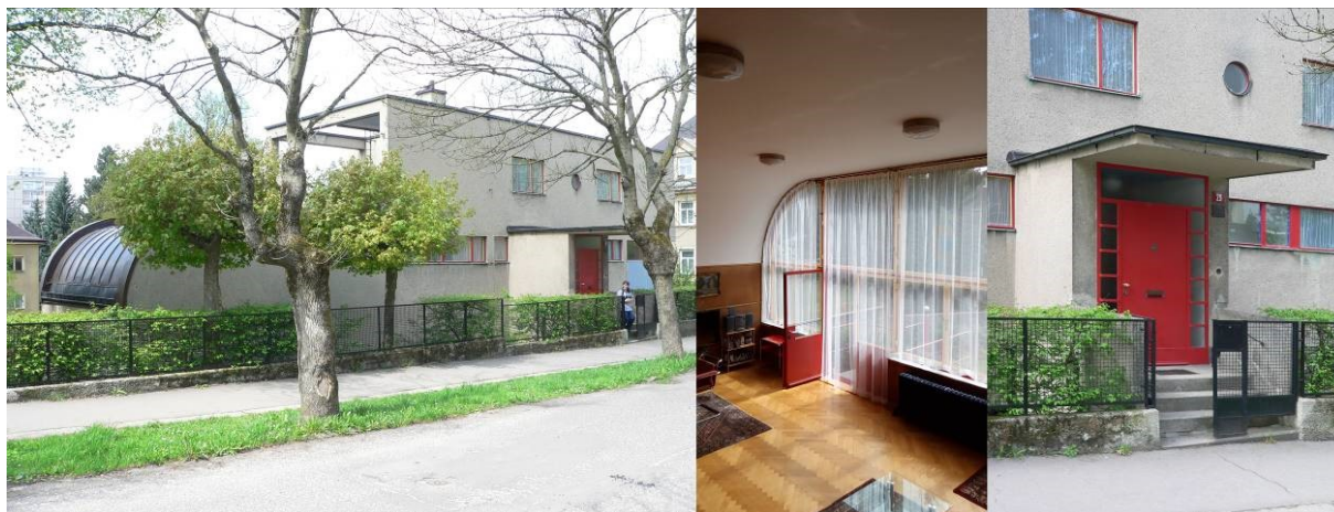
336. Schmelowského vila. Pohled z Opletalovy ulice, interiér obývacího pokoje a hlavní vstup do domu. Foto autor 2016.
