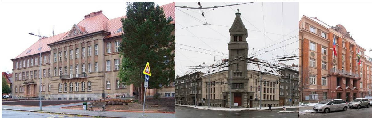
351. Národní sloh. Masarykova škola na Jiráskově náměstí (1919-23), Husův sbor v Němejcově ulici (1924-25) a budova finančních úřadů, tzv. Rašínův dům ve Škroupově ulici (1924-27). Foto autor 2007, 2017.
