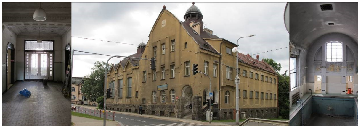
289. Jablonecké lázně, současný neutěšený stav. Vstupní vestibul, celkový pohled a plavecká hala. Foto autor 2016.
