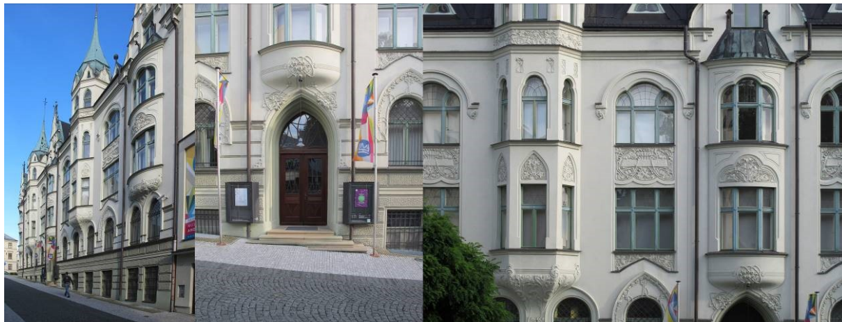
275. E. Herbig. Někdejší exportní dům Zimmer & Schmidt. Hlavní průčelí, detail vstupu a fasády. Foto autor 2016.
