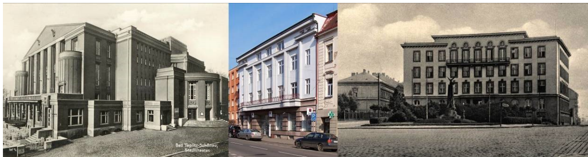
398. Klasicizující tendence. Monumentální nové divadlo v Teplicích (1921-24, R. Bitzan), Eskomptní banka v Lovosicích (1928-29, F. Lehmann) a ředitelství Severočeských hnědouhelných dolů v Mostu (1930-31, Lossow & Kühne). Archiv autora, foto autor 2013.
