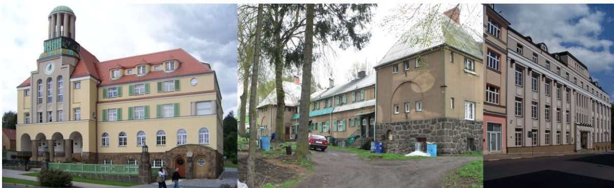
392. Reformní architektura v díle Rudolfa Bitzana. Radnice ve Freitalu-Döhlen (1914-15), zaměstnanecký dům Jutových závodů ve Višňové (1920-22) a administrativní budova NEW v Děčíně-Podmoklech (1921-23). Foto autor 2011, 2013.
