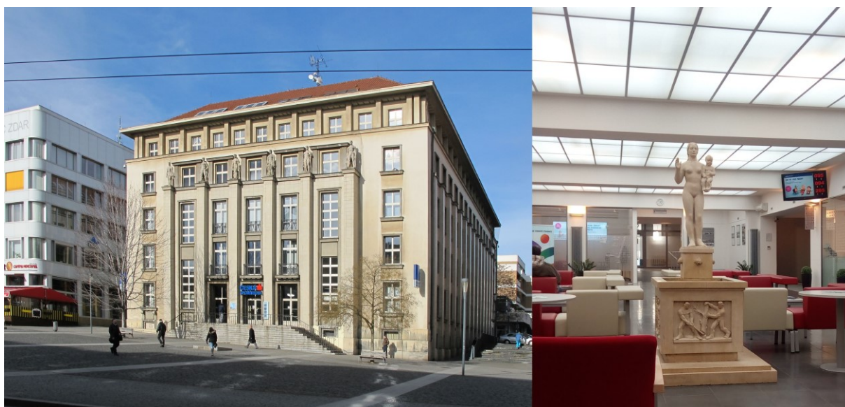
93. F. J. Arnold. Budova spořitelny na Mírovém náměstí. Hlavní průčelí s alegorickou sochařskou výzdobou a interiér haly s figurální kašnou. Foto autor 2016.
