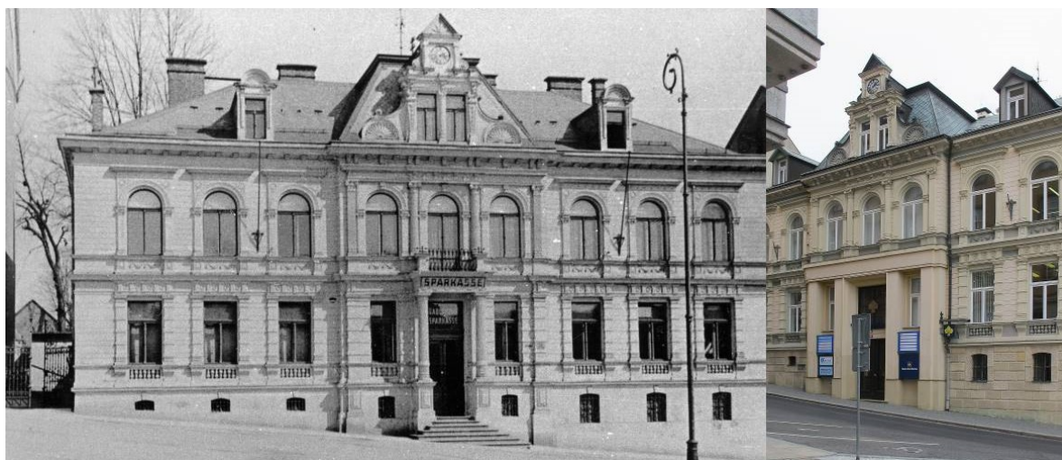
267. E. Trossin. Bývalá škola, později spořitelna na Mírovém náměstí. SOkA Jablonec, foto autor 2016.
