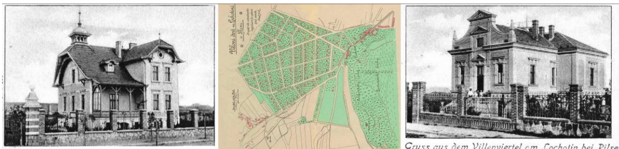
345. Zastavovací plán vilové čtvrti v Lochotíně a typická zástavba čtvrti na výřezu z historické pohlednice. Villová čtvrť král. města Plzně na Lochotíně 1901, archiv autora.
