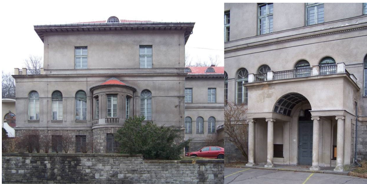
87. E. Rentsch. Průčelí vily C. H. Wolfruma směrem do ulice Velká Hradební a hlavní vstup do domu. Foto autor 2014.
