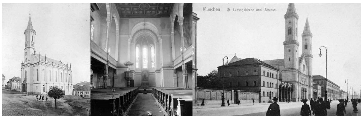
162. G. Sachers. Evangelický kostel na náměstí Českých bratří na historickém snímku a pohled ke kněžišti krátce před demolicí. Historická pohlednice sv. Ludvíka v Mnichově (1829–44) od Friedricha von Gärtnera. SM, archiv NPÚ, ÚOP v Liberci, archiv autora.
