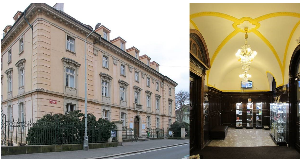
116. P. Brockhardt. Palácová vila Hanse Weinmanna, hlavní průčelí a vstupní vestibul. Foto autor 2016.
