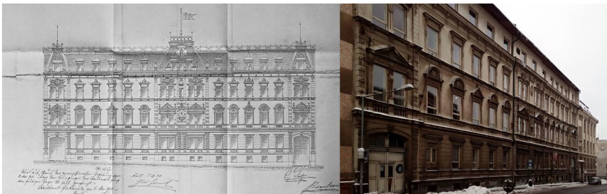
271. C. Daut. Exportní dům Haasis. Návrh sjednocení průčelí v rámci nástavby patra v roce 1900 a současný stav. MMJ, ASÚ, foto autor 2016.
