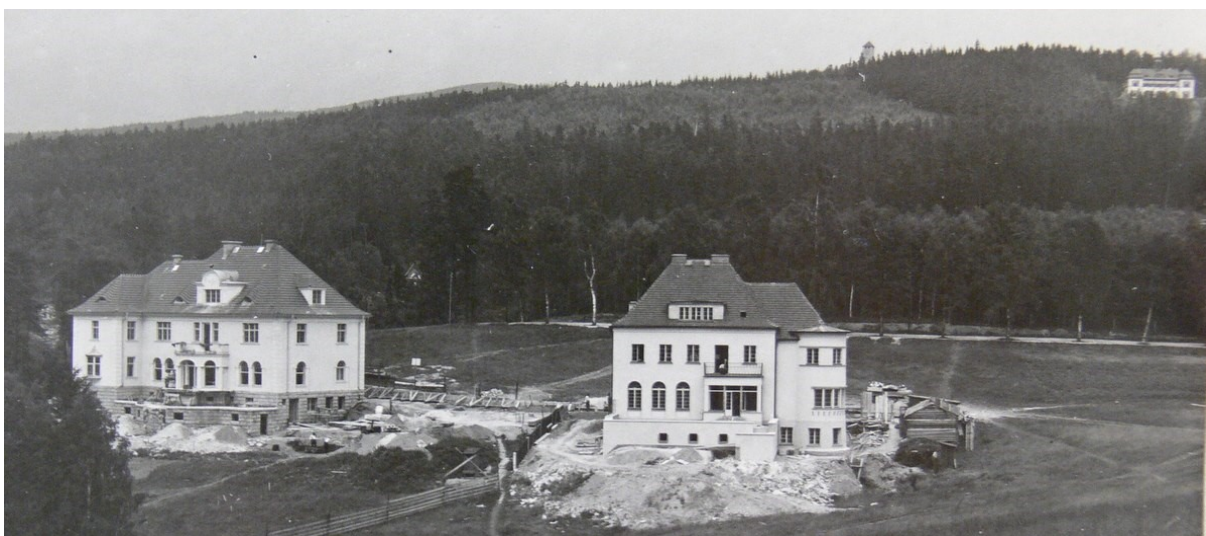
236. Nově vznikající zástavba v Třebízského ulici. Vpravo rozestavěná vila Eduarda Adama od žitavské kanceláře Löwe & Wäntig, investorem rozložitého sousedního domu byl Felix Irsing a autorem projektu Oskar Rössler. Archiv autora.
