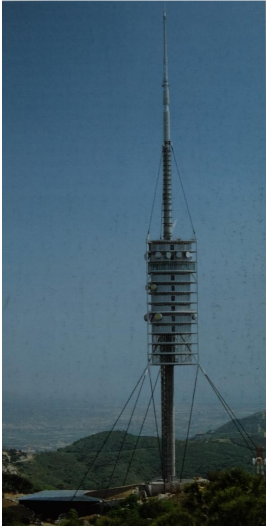
20. Telekomunikační věž, Španělsko
