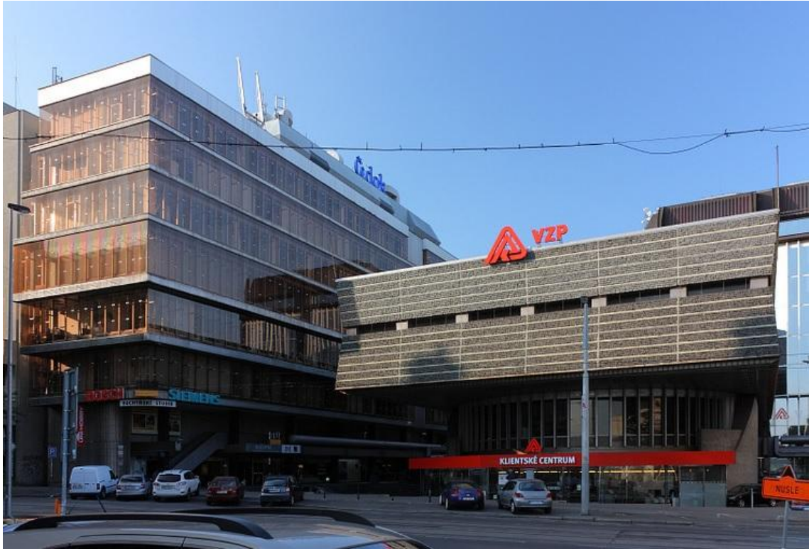
63. Soubor staveb bývalého Plynárenského centrálního dispečinku Transgas a současně Ministerstva paliv a energetiky. Pohled na Transgas z Vinohradské ulice.
