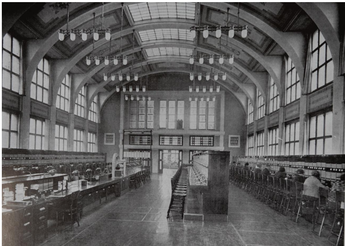
2. Pohled do sálu s jednotlivými pracovišti v bývalé Mezinárodní telefonní a telegrafní ústředně ve Fibichově ulici
