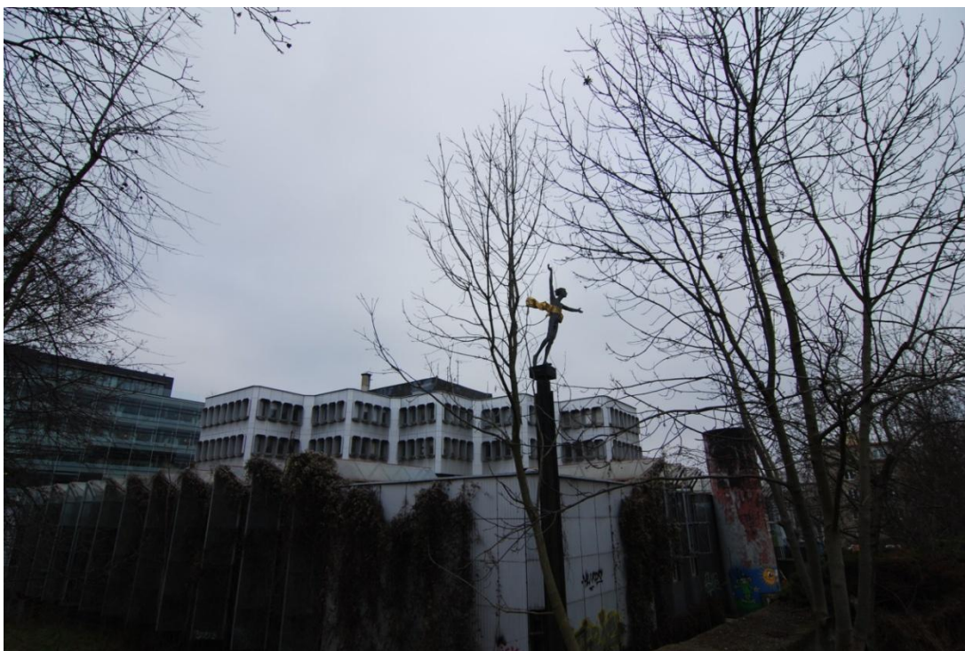
47. ATU Dejvice, pohled na jihozápadní nároží telefonní ústředny spolu se sochou Vítěze
