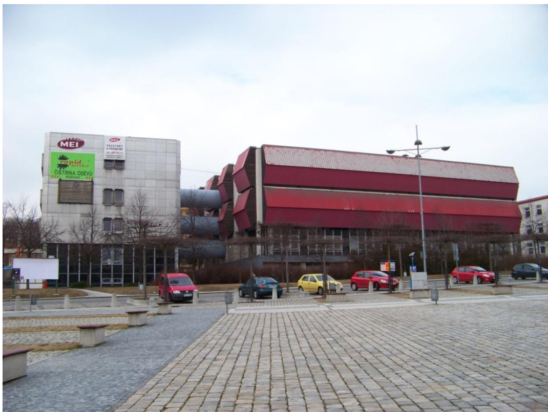
52. Telekomunikační budova v Teplicích
