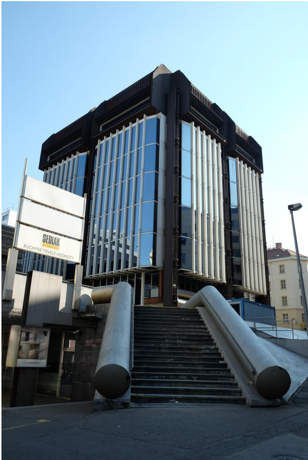
60. Soubor staveb bývalého Plynárenského centrálního dispečinku Transgas a současně Ministerstva paliv a energetiky. Pohled na administrativní část komplexu ze Škrétkovy ulice.
