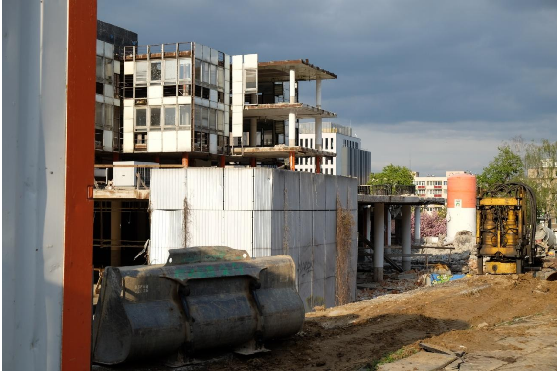
65. Pohled na demolici telefonní ústředny v Dejvicích
