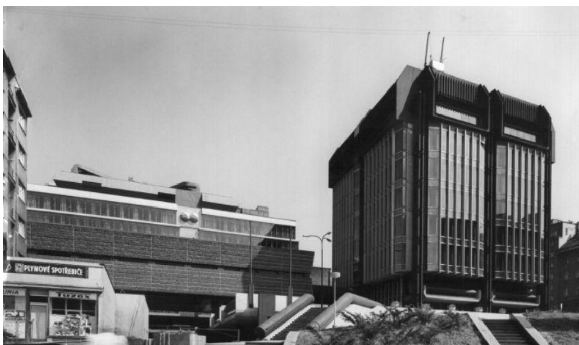
14. Soubor staveb bývalého Plynárenského centrálního dispečinku Transgas a současně Ministerstva paliv a energetiky
