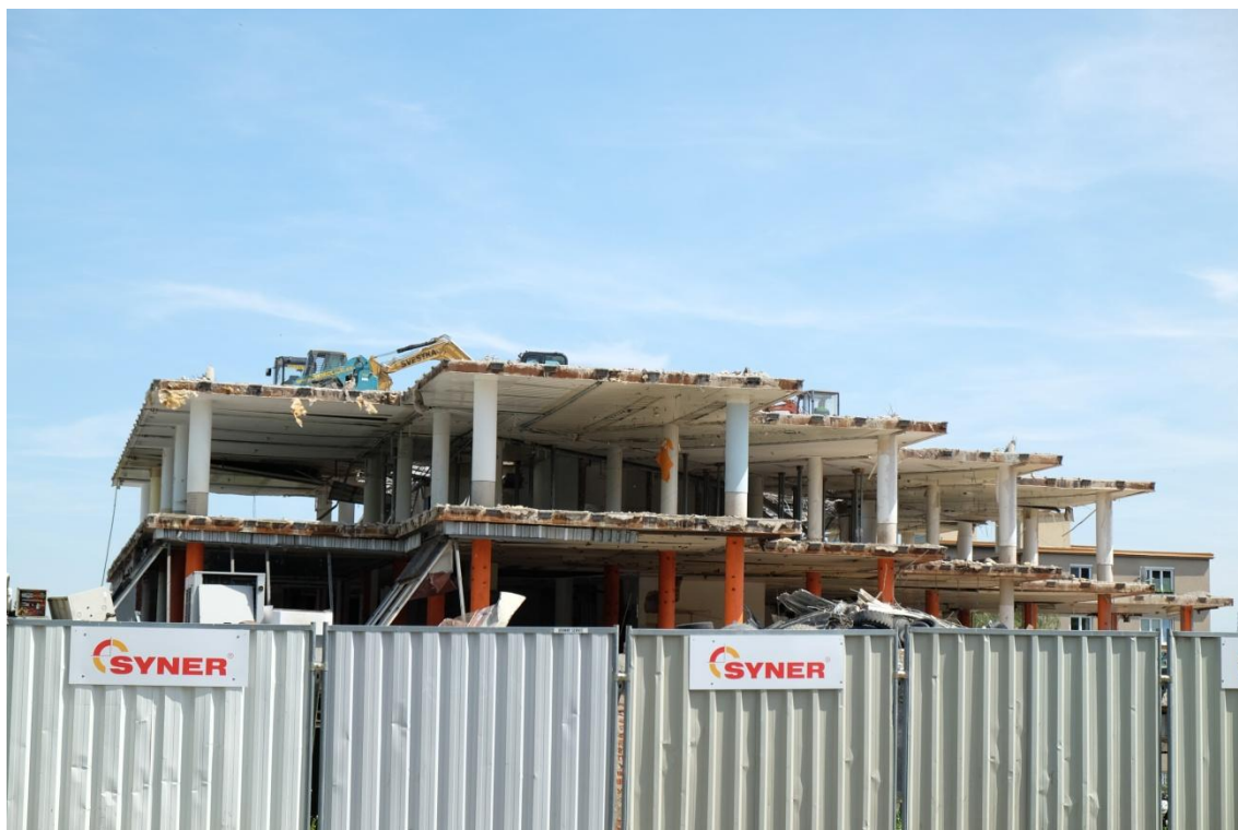
67. Pohled na demolici telefonní ústředny v Dejvicích
