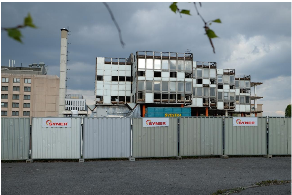
66. Pohled na demolici telefonní ústředny v Dejvicích
