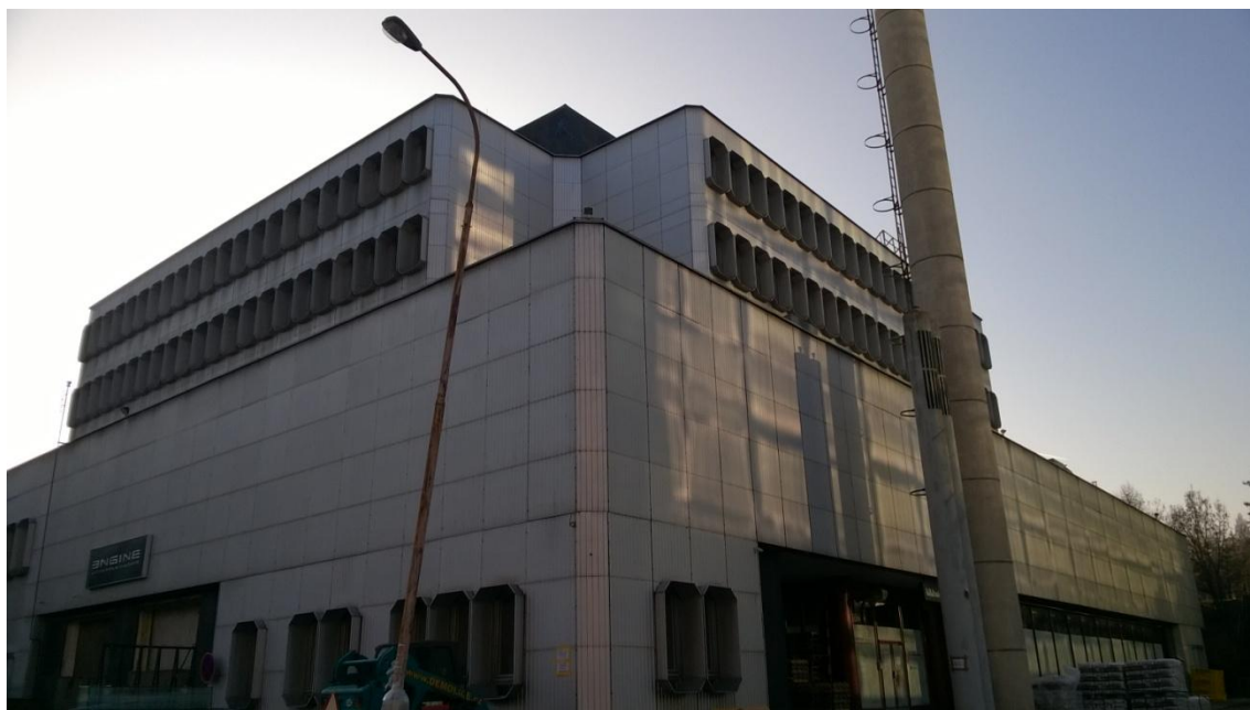
35. ATU Dejvice, pohled na severovýchodní nároží stavby
