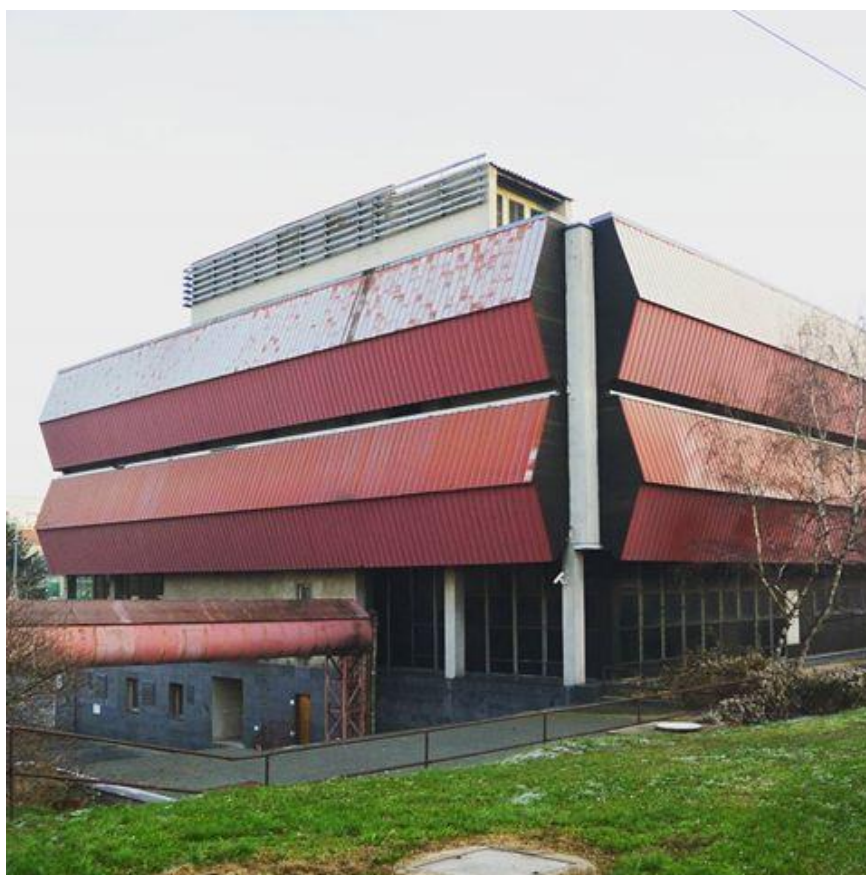
54. Telekomunikační budova v Teplicích
