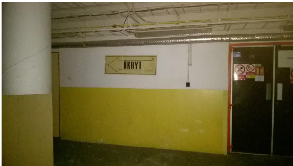
45. ATU Dejvice, pohled do jedné z chodeb v útrobách stavby
