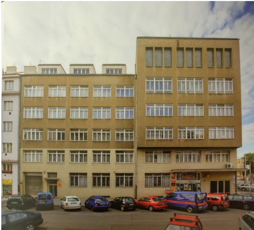
8. Poštovní úřad s automatickou telefonní ústřednou v Dejvicích
