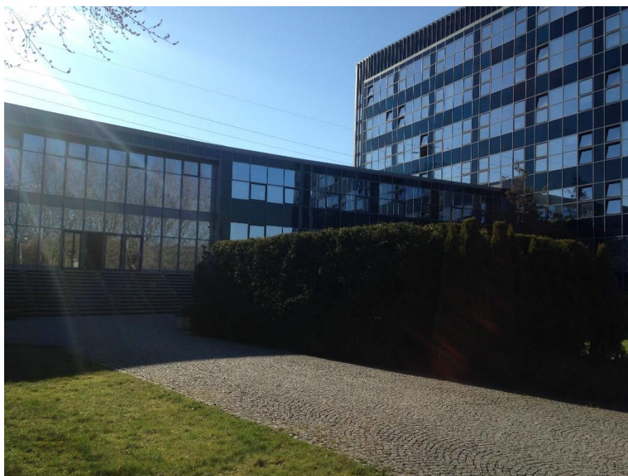
Obr.1. Makromolekulární ústav. Hlavní vstup s chodbou a laboratorní část budovy. Rok 2017.
