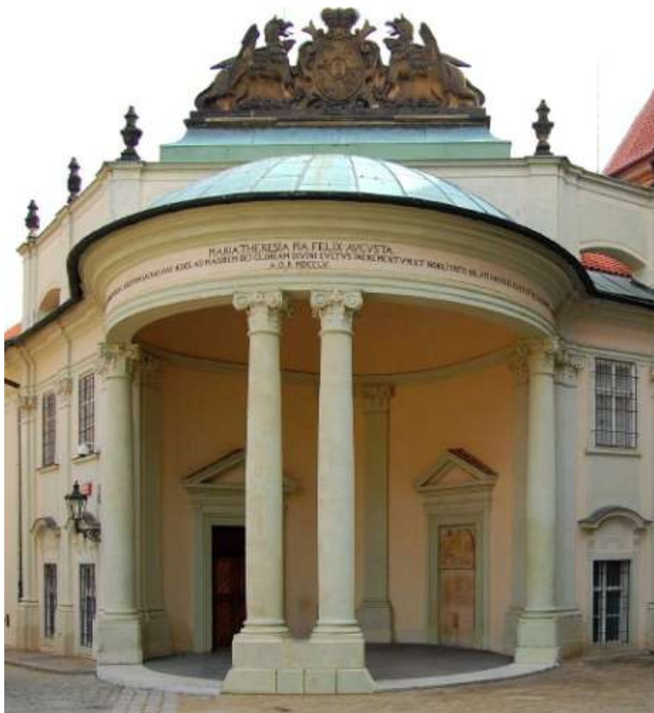
14). Ústav šlechtíčen na Pražském hradě, architekt: N. Pacassi, 1753-1755
