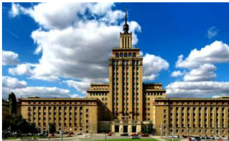
56. František Jeřábek a kol. : Grandhotel International, Praha-Dejvice
