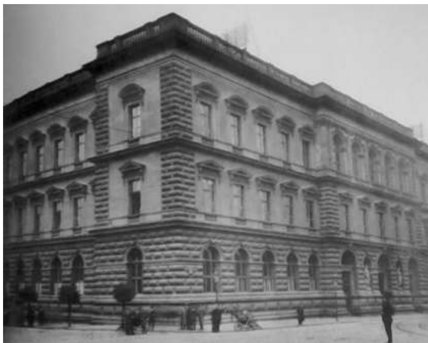
27. Ignác Ulmann : budova dnešního ČVUT, Praha, Karlovo náměstí (býv. Český polytechnický ústav), 1871-1873, novorenesance se zde projevuje plasticitou a výraznými bosážemi na nároží a v soklové části stavby
