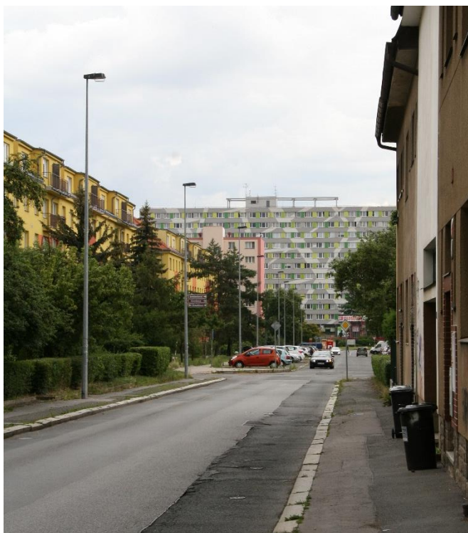
43. Praha, Zahradní město, Jabloňová ulice, v pozadí internát ve východní části sídliště
