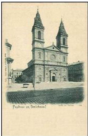
3. Kostel sv. Václava na Smíchově. Pohled na západní průčelí, 1898.
