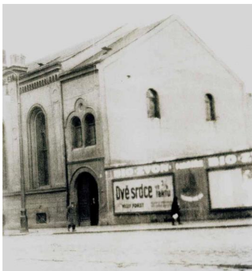
35. Smíchovská synagoga. Podoba budovy před přestavbou v letech 1930—31.
