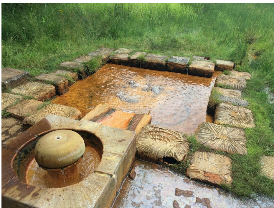
Obr. 4 Aktuální podoba jímky císařského pramene s výrazným zastoupením sraženiny tvořené oxidy trojmocného železa.
