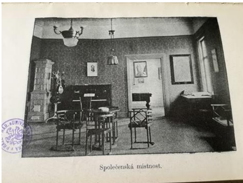
příloha 6: Společenská místnost v Tuchlově (Konařík, 1934).
