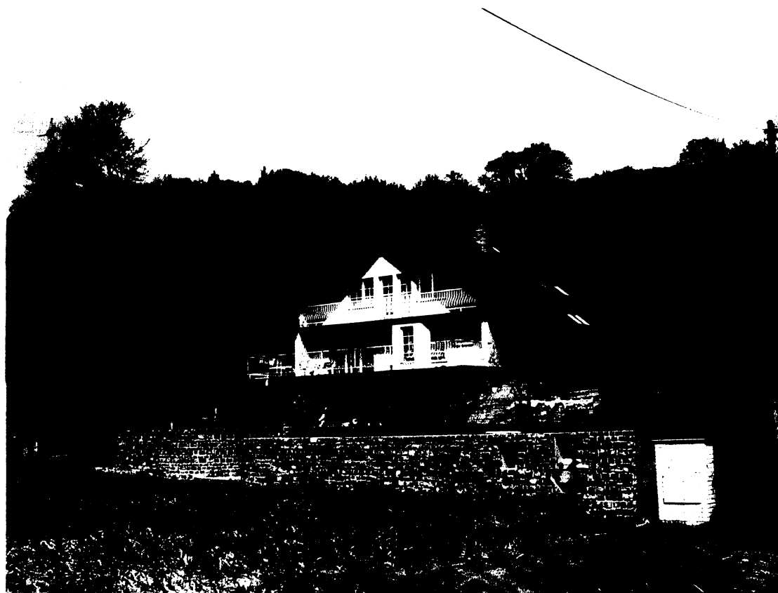
Obr. 11: Stavba nevyhovující požadavkům CHKO
