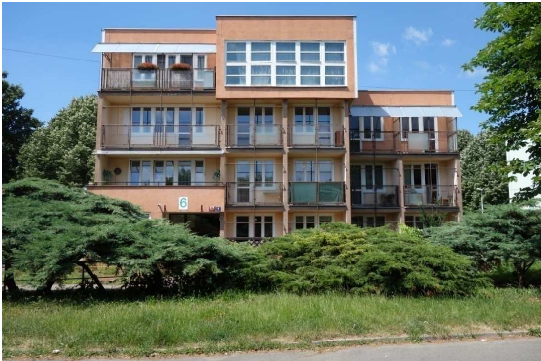
Obrázek 6.7: Panelová zástavba v ulici Řepínská v UO Za čimickým hájem
