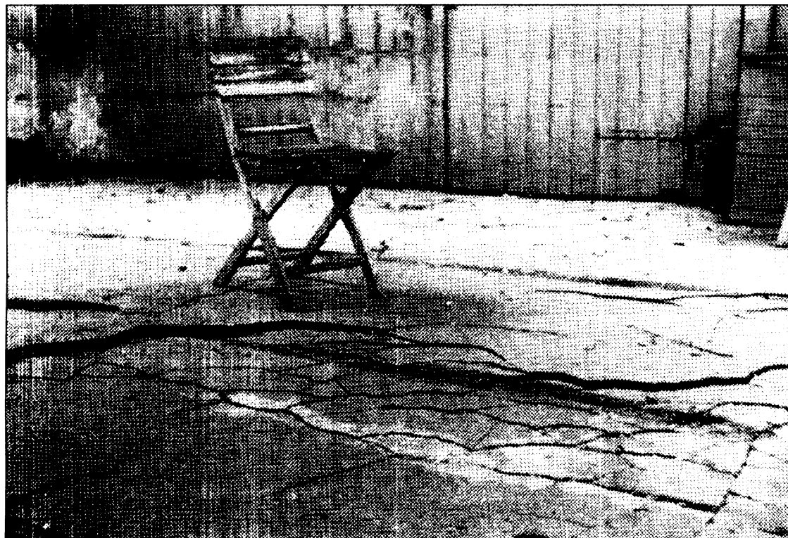
Fotografie č.1 - Odlučné trhliny na terase zahradní restaurace Nebozízek (převzato z M. Špůrek, 1978)
