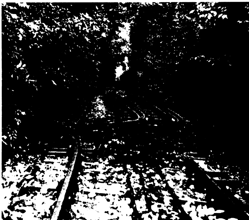
Obrázek 5 - Porucha kolejnic při petřínském sesuvu
