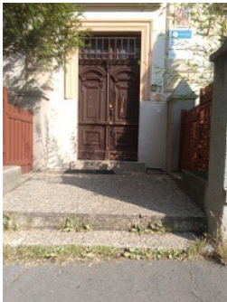
(Obr. č. 32, MOP Strašnice)
