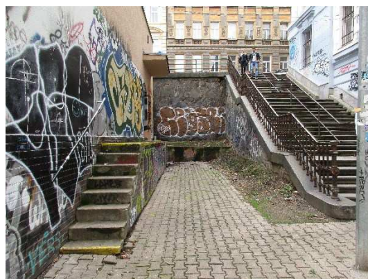
Obrázek 30: Schodiště vedoucí z Husinecké ulice na Kostnické náměstí umístěné v zákrytu trafostanice Zdroj: vlastní fotodokumentace
