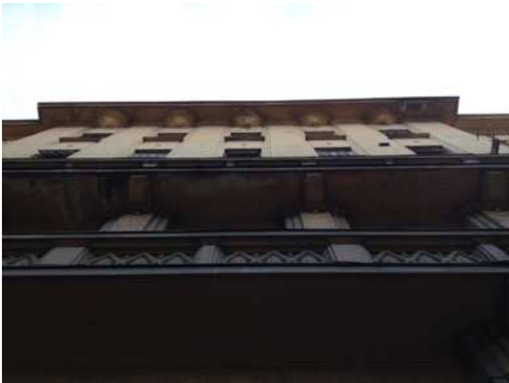
obr. č. 103 Spodní pohled na čelní rizalit
