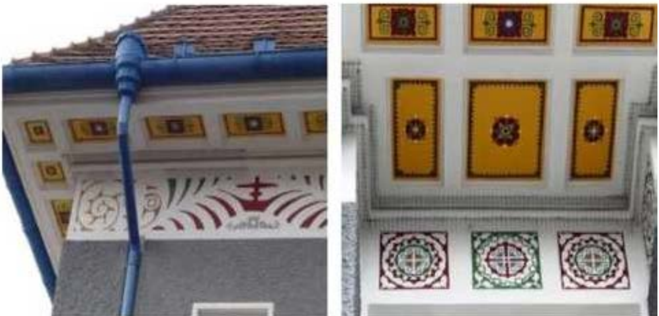
obr. č. 138 a 139 Kazetování korunní římsy se secesním ornamentem do Jano Köhlera
