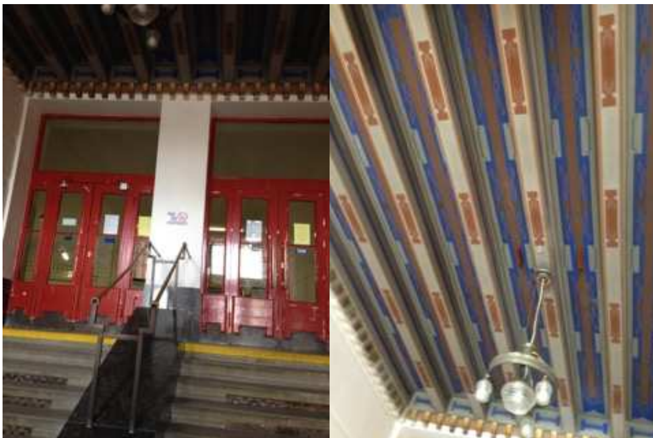
obr. č. 120 a 121 Vestibul a detail stropu
