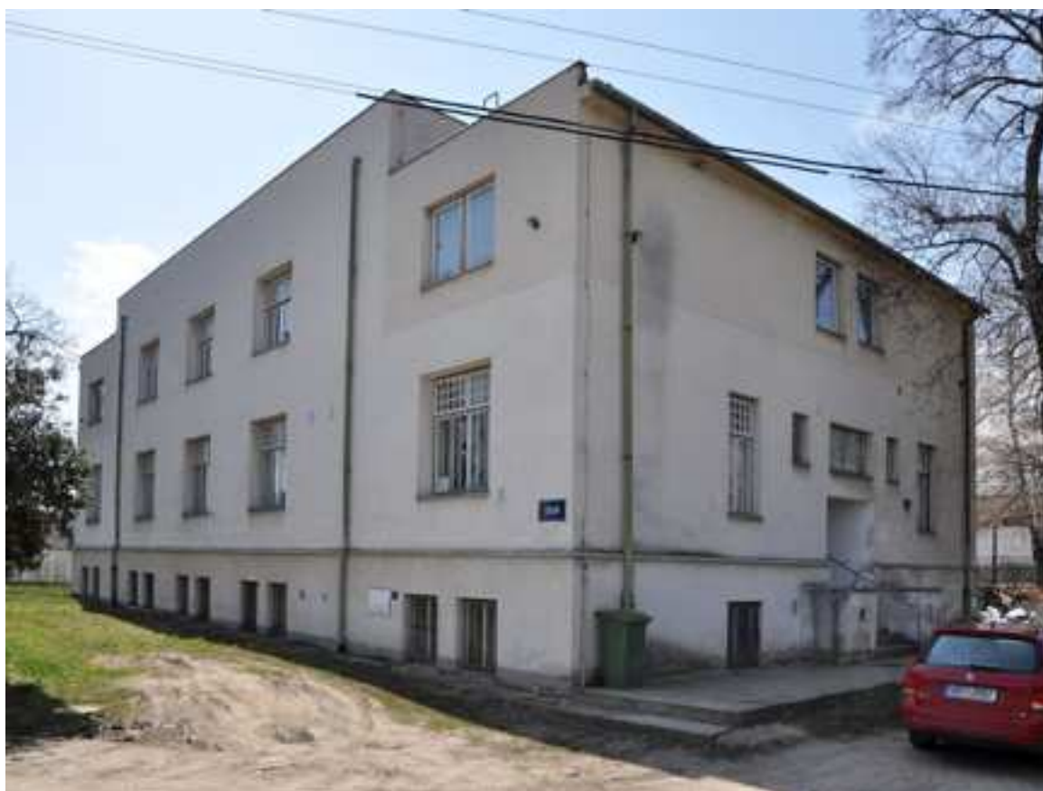
obr. č. 80 Bauerova vila od Adolfa Loose v Hrušovanech u Brna
