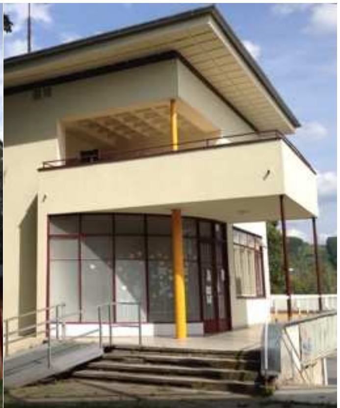
obr. č. 132 a 133 Vyložená korunní římsa s kazetováním
