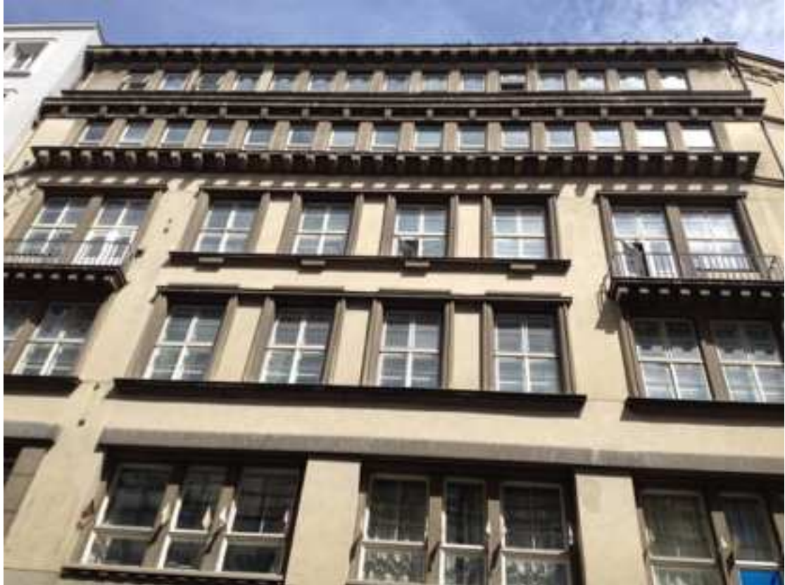
obr. č. 106 Detailní pohled na fasádu a římsy se zubořezem
