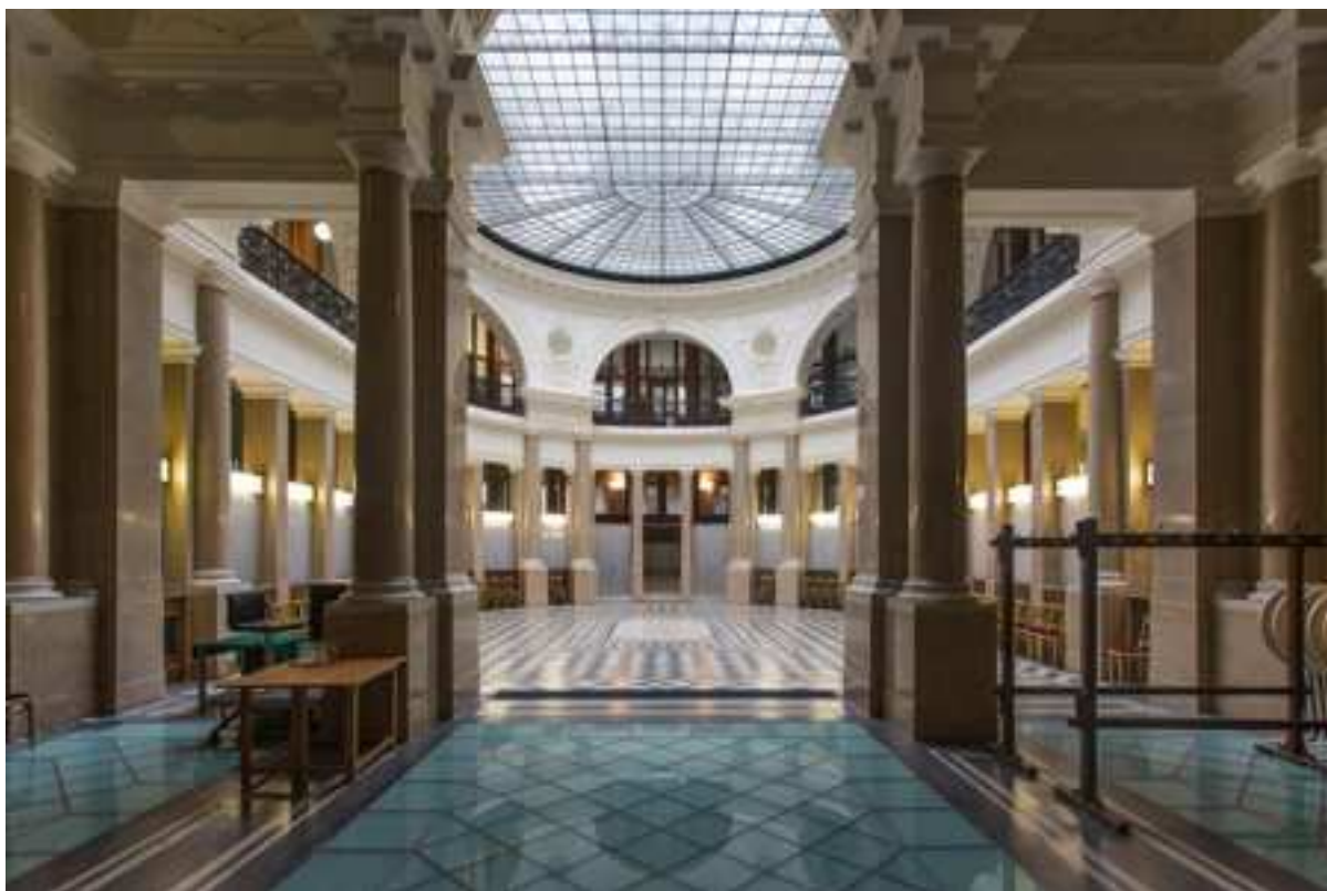
obr. č. 15 Hala s proskleným stropem a skleněnými podlahami v budově Länderbank
