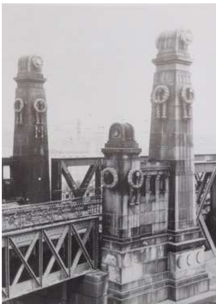
obr. č. 8 Antikizující hmotná konstrukce nosných pilířů Stadtbahnu vychází z dórského slohu
