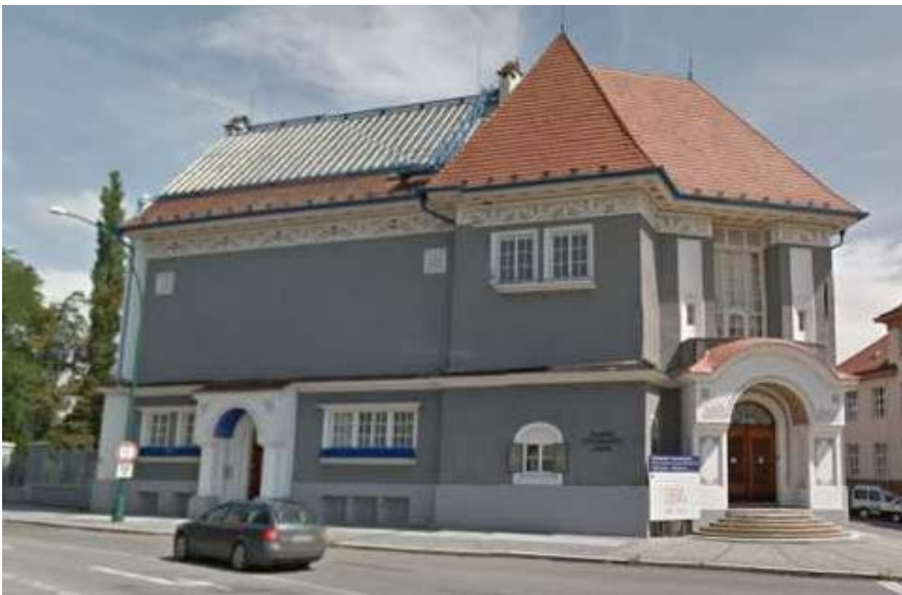
obr. č. 135 Pohled na západní křídlo s rizalitem
