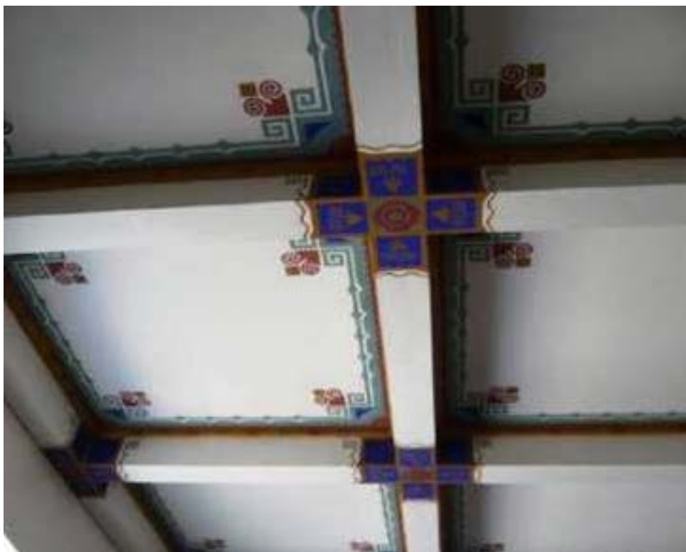
obr. č. 142 Trámování ve vestibulu
