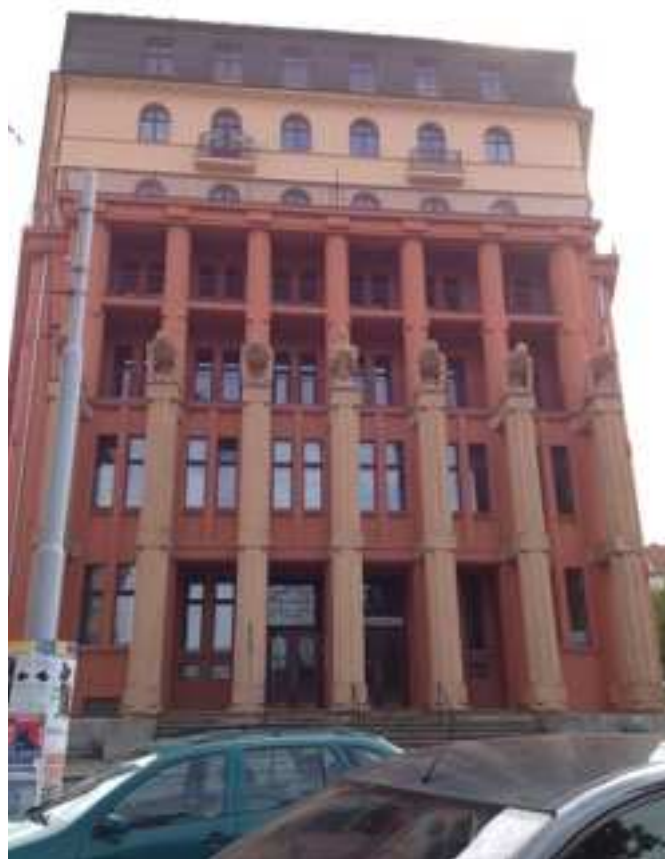
obr. č. 119 Čelní pohled na průčelí
