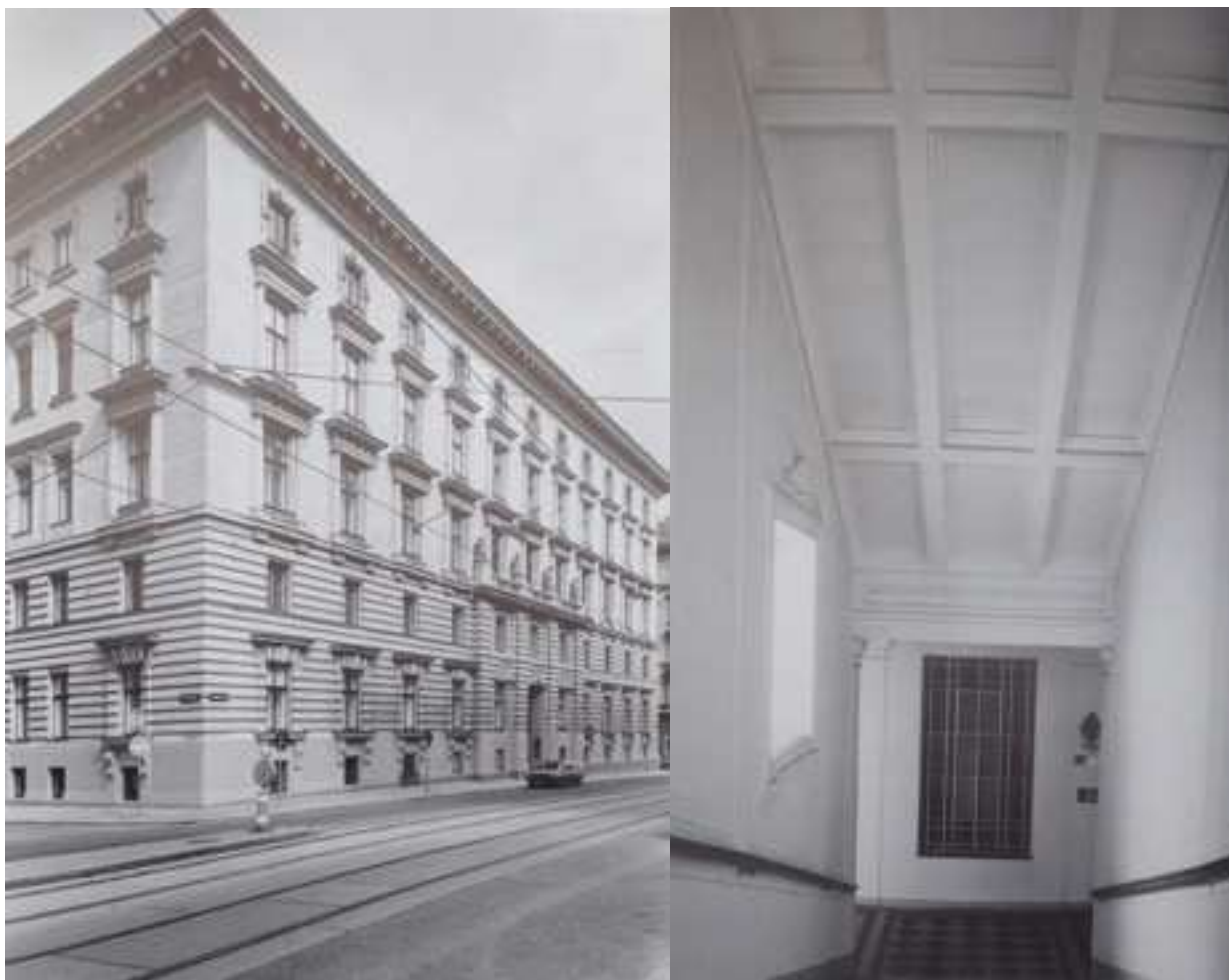
obr. č. 9 a 10 Obytný dům na Stadiongasse a pohled na trémový kazetový strop schodiště
