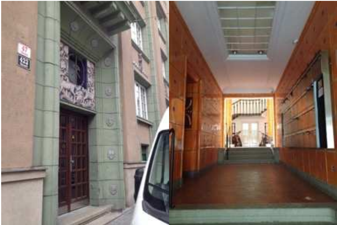
obr. č. 112 Vstupní portál
