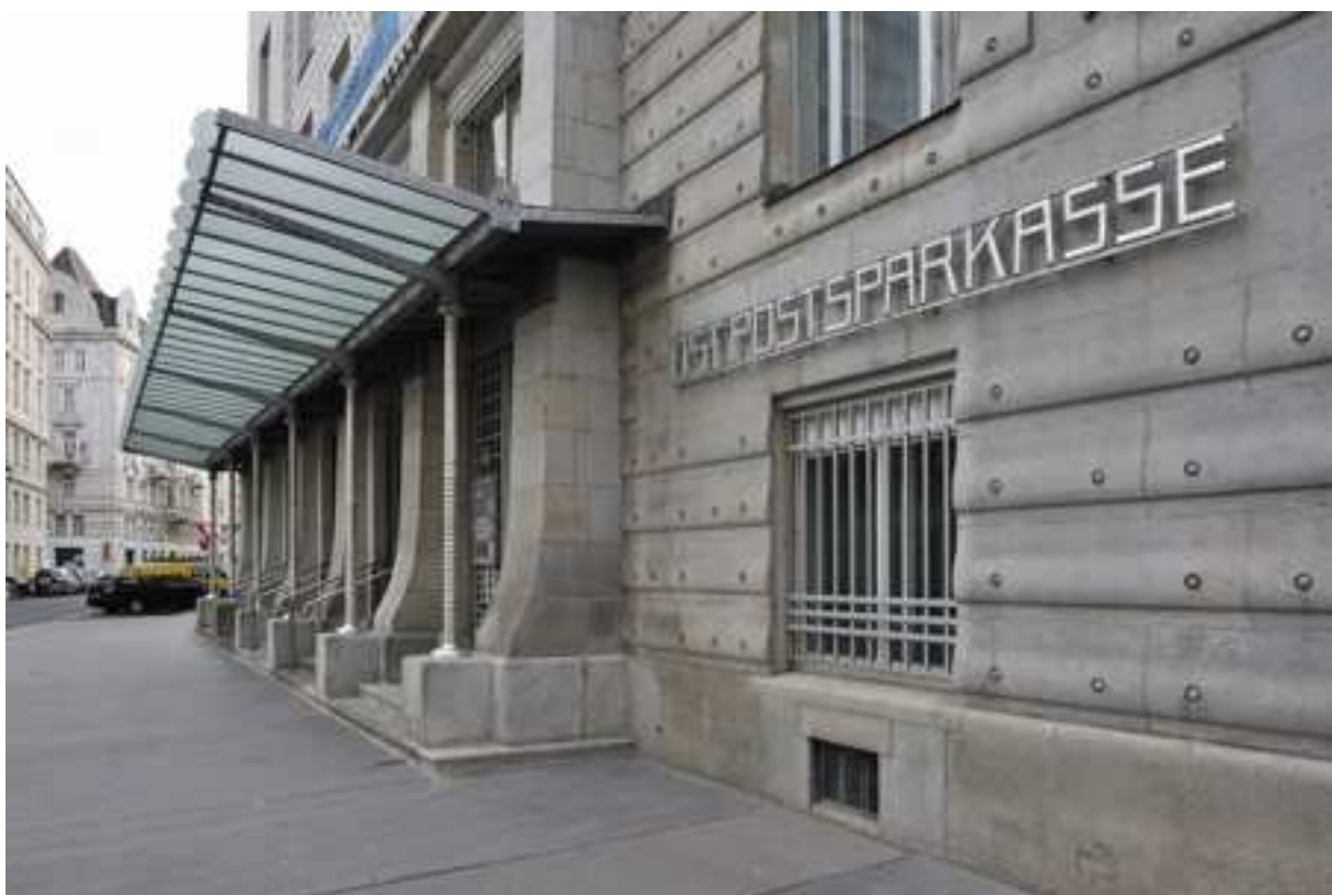
obr. č. 20 Robustní hmota stavby je odlehčena hliníkovou a skleněnou konstrukcí markýzy
