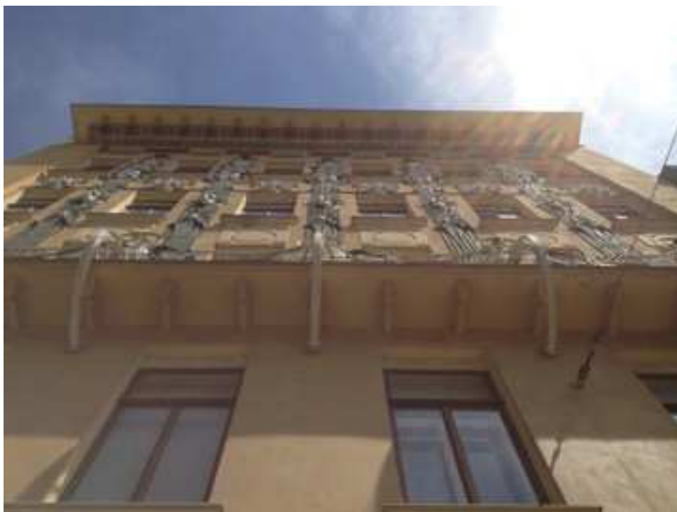
obr. č. 84 Detail fasády domu na Veverčí
