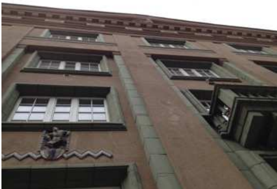
obr. č. 111 Detailní pohled na fasádu
