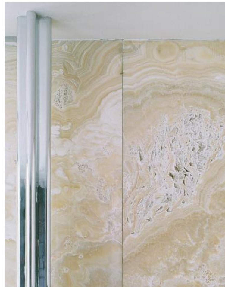
Obr. 26 Ludwig Miese van der Rohe: Detail onyxové stěny. Vila Tugendhat, 1928-30, Brno, ČR.
