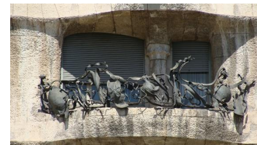
Obr. 45 Antoni Gaudí: Kované železné zábradlí velkých balkonů na Casa Milá, je zpracováno do abstraktních a rostlinných tvarů
