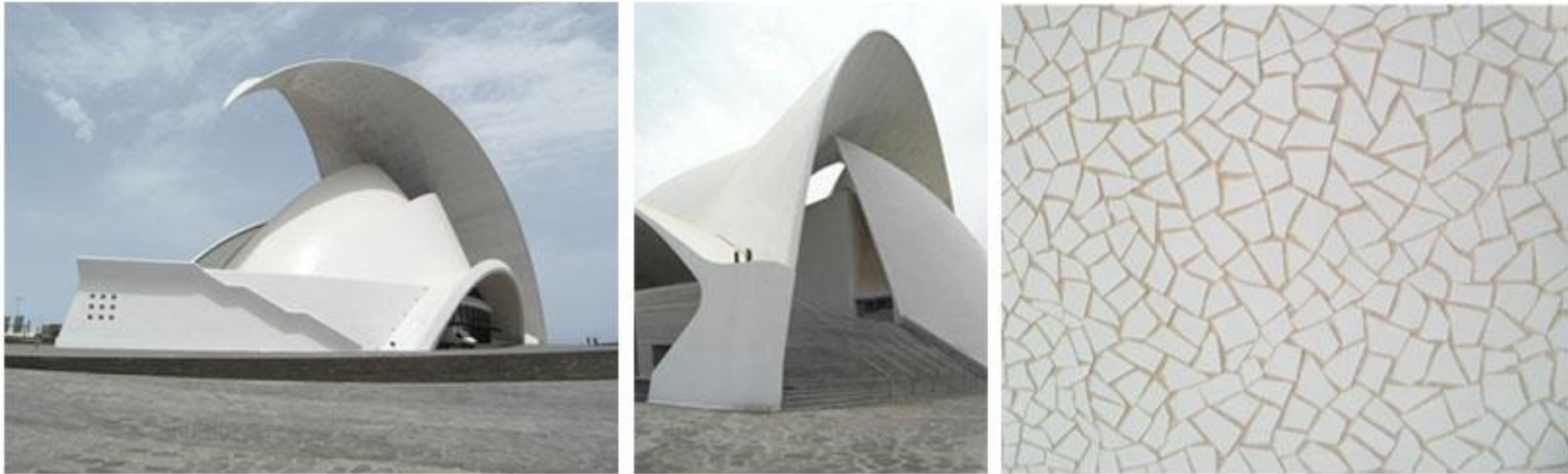
Obr. 2-4 Santiago Calatrava: auditorium na Tenerife, 1991–2003, Španělsko. (Zleva doprava) celkový pohled / bližší záběr na zakřivenou skořepinovou střechu, jejíž tvar se díky perspektivě výrazně mění. Budova je stále se proměňující abstraktní skulpturou / detail obložení skořepinové konstrukce.
