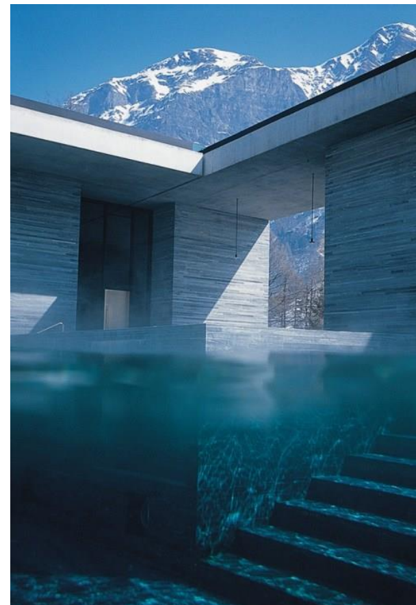
Obr. 14 Peter Zumthor: termální lázně ve Valsu, 1996, Švýcarsko. Zumthor pracuje s přírodními materiály, které úzce souvisejí s místem vzniku stavby, aby docílil užšího sepětí člověka s prostředím. V tomto případě použil kámen, který se vyskytuje ve Valsu. Stavba je zasazena do svažitého terénu a navenek působí jako obrovský porézni kámen, čímž nikterak nenarušuje okolí. Naopak, vypadá, jakoby tam stála odjakživa.
