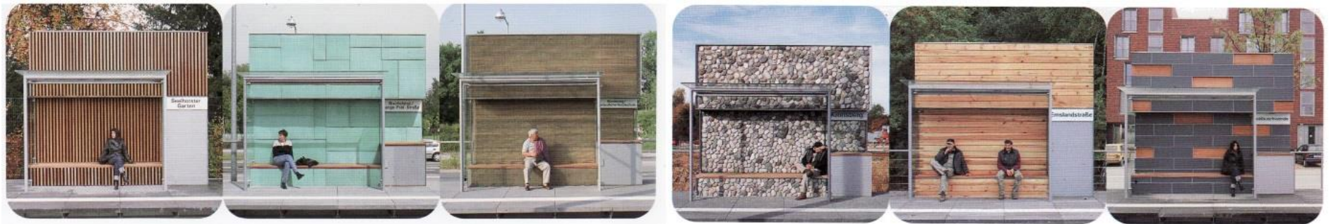
Obr. 11 Despang Architekten – Tramvajové zastávky linky D v Hannoveru. Konceptně a designově velmi silné řešení, které nepostrádá nápad a vtip, podpořené navíc citem pro skromnost a neokázalost.
