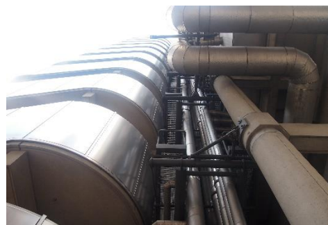
Obr. 47 Richard Rogers: Detail obnažené konstrukce pojišťovny
