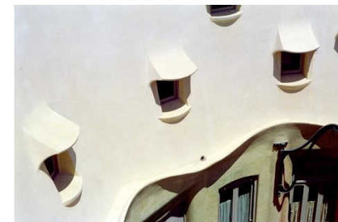
Obr. 50 Antoni Gaudí: Detail menších střešních oken na Casa Milá. Ve spodní části fotografie jsou vidět větší okna do dvora
