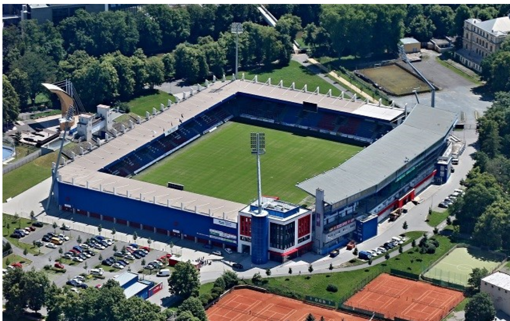
Pohled na Doosan Arénu zpoza hlavní tribuny. I po rekonstrukci bylo zachováno červenomodré provedení.
