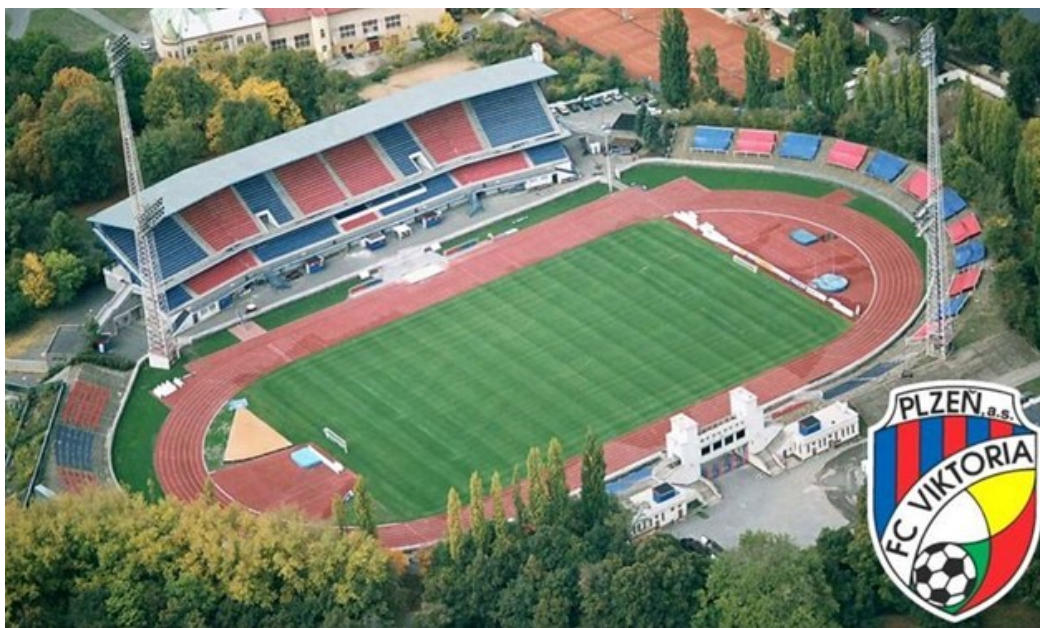
Pohled na hlavní tribunu Doosan Arény.
