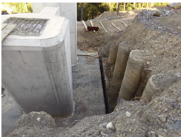
Obr. č. 43: Pilotová stěna okolo mostního pilíře (vlastní dokumentace)
