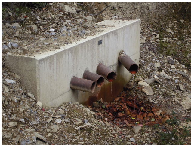
Obr. č. 44: Vyústění subhorizontálních odvodňovacích vrtů (vlastní dokumentace)
