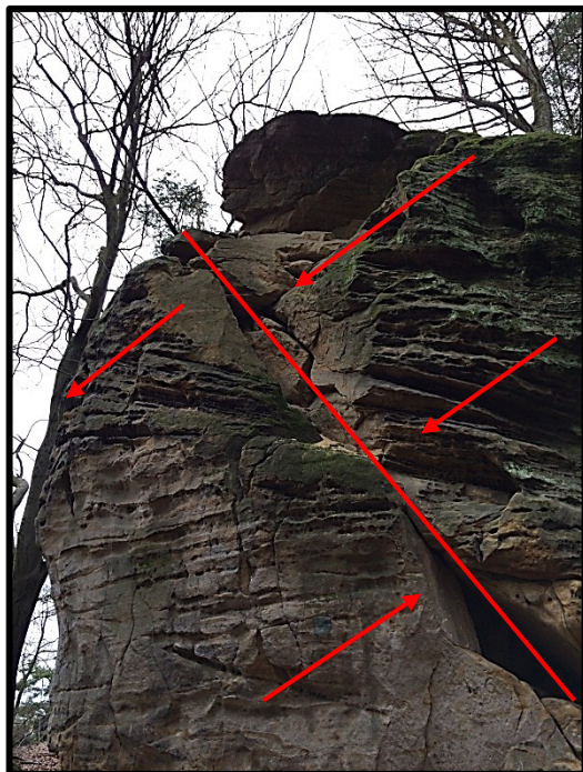
Obrázek 24. Náčrt pohybu věže, horní část pukliny se rozevívá a spodní uzavírá, pohled z jihozápadní strany
