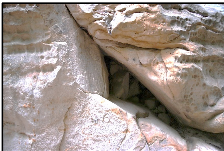
Obrázek 51. Puklina po vyčištění
